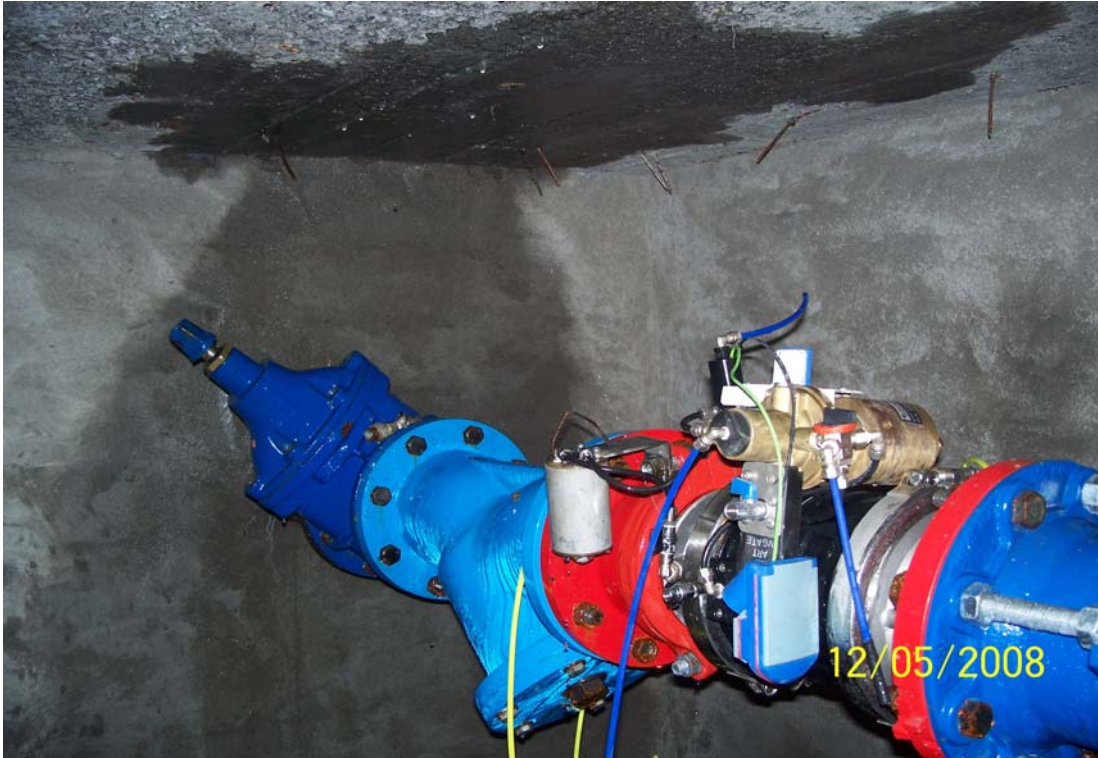
Şekil 3.7. Montajı yapılmış bir basınç düşürücü vana ( tek pistonlu).
