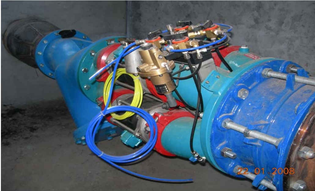
Şekil 3.6. DN400’lük 6 pistonlu basınç düşürücü vananın şebekeye bağlanmış şekli.
