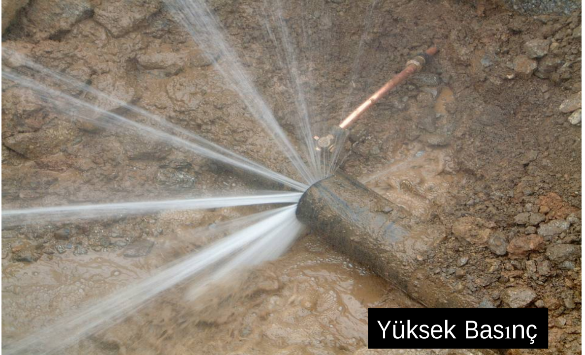
Şekil 3.19. Yüksek basınç altında hattan kaçan su miktarı (7 bar).
