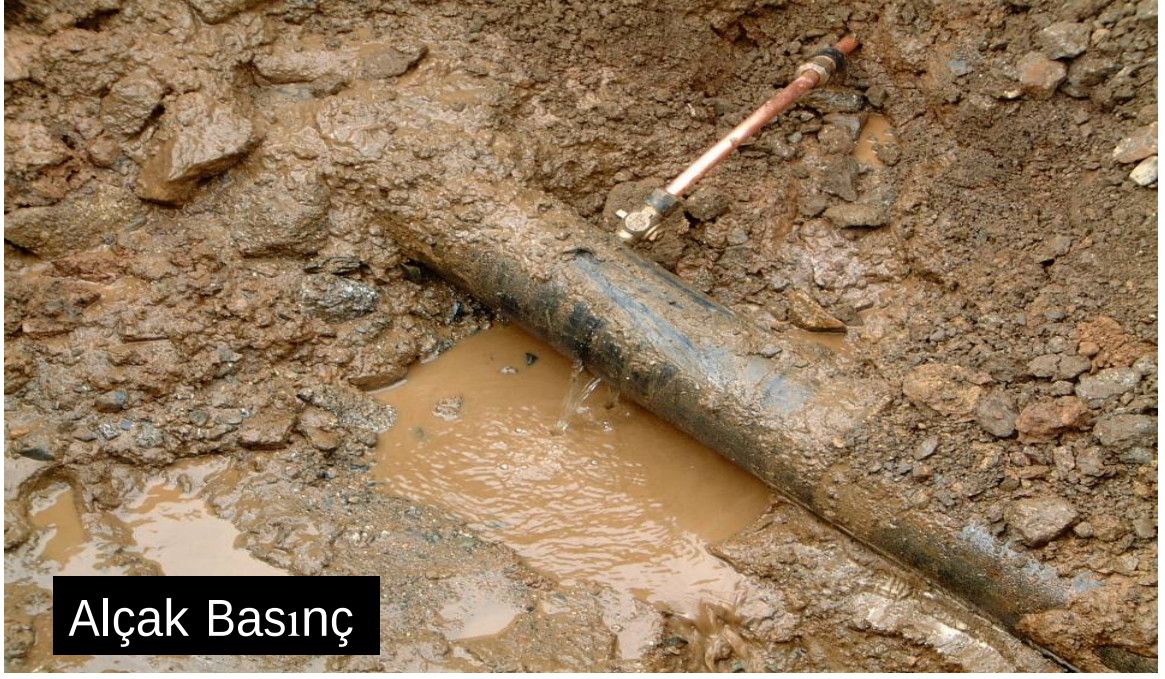
Şekil 3.18. Alçak basınç altında hattan kaçan su miktarı (1 bar).
