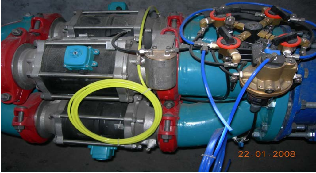
Şekil 3.5. DN400’lük 6 pistonlu basınç düşürücü vana.
