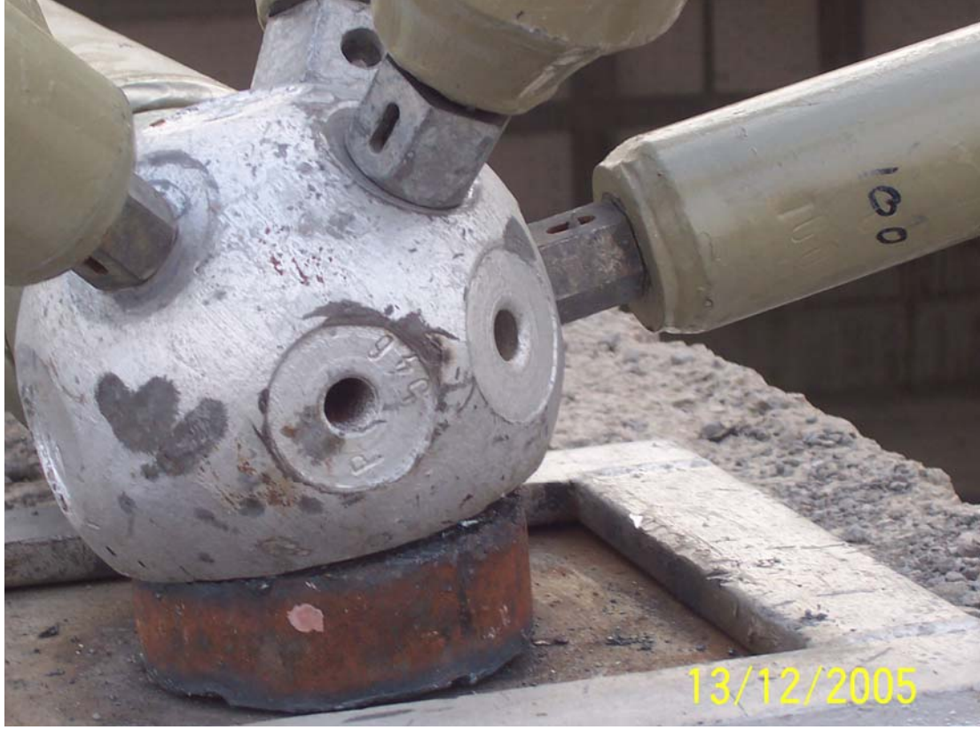
Şekil 3.3 Çubukta Montaj Numarası (100) Yazılan Eleman ve Temas Yüzeyinin Artırılması
