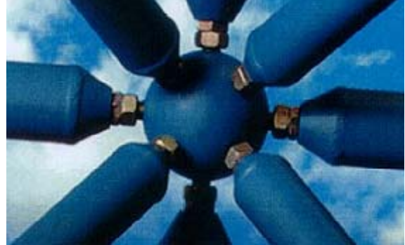
Şekil 3.1 Uzay Kafes Sistemlerde Düğüm Noktası (Küre Eleman)
