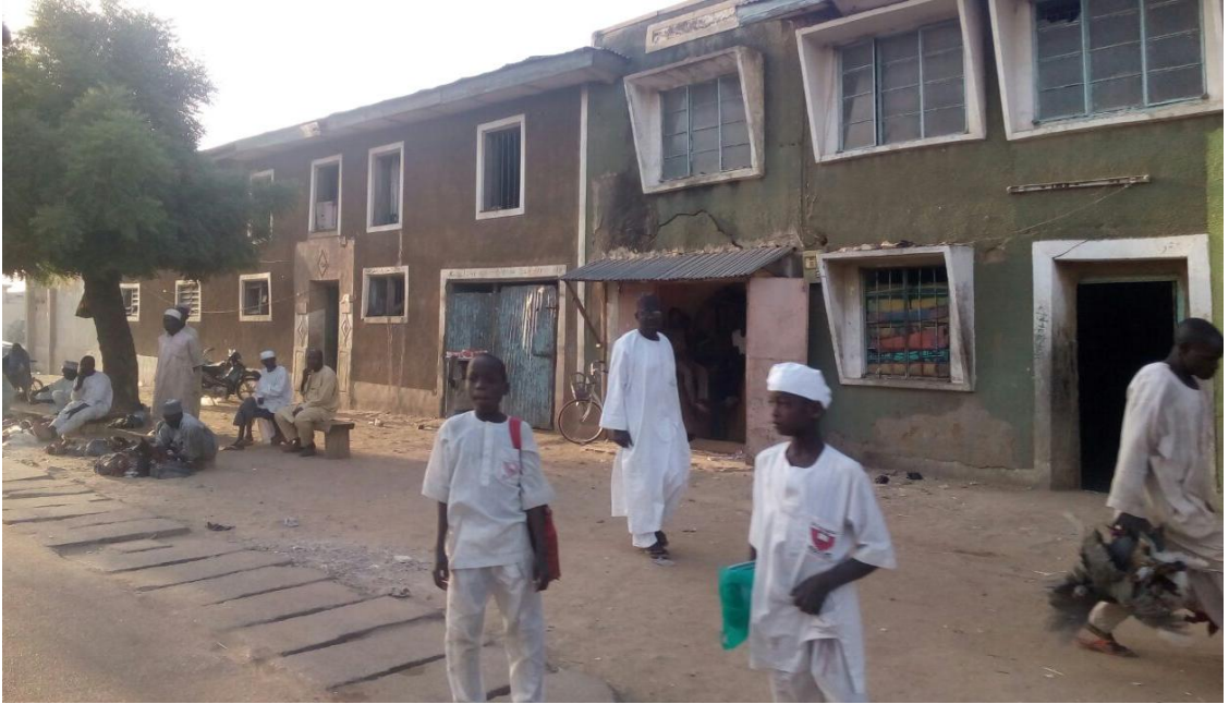
Foto 25: Kano Şehrinde Modern Yapı Malzemeleri ile Yapılan Bir Ev
