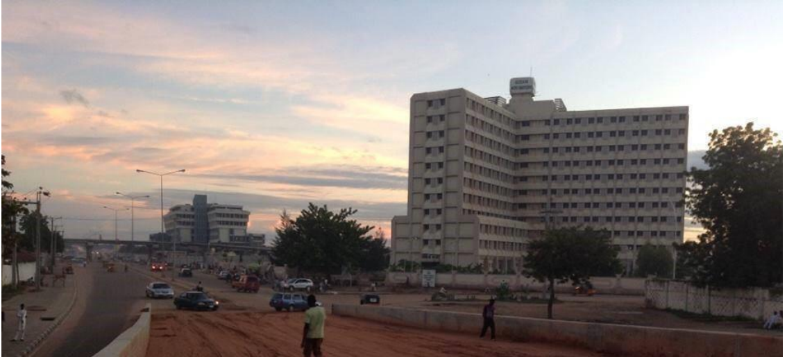
Foto 17: Kano Şehrinin Merkezi İş Sahasında Modern Avrupa Mimarisi ile Yapılan İş Yeri
