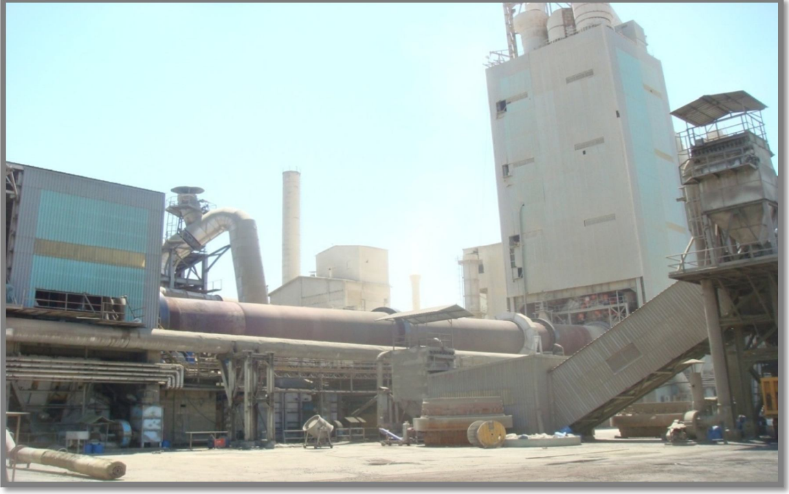
Foto 12: Döner Fırın ve Siklonlar 1-2-3-4 ve Ayna Karşıdan Görünüm Scanner Kulesi Fırın Dış Manto Sıcaklığını Ölçer
