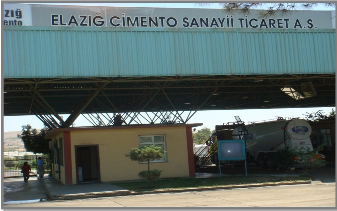
Foto 1: Fabrika Ana Giriş Kapısı ve Tonajlı Kantar Yeri
