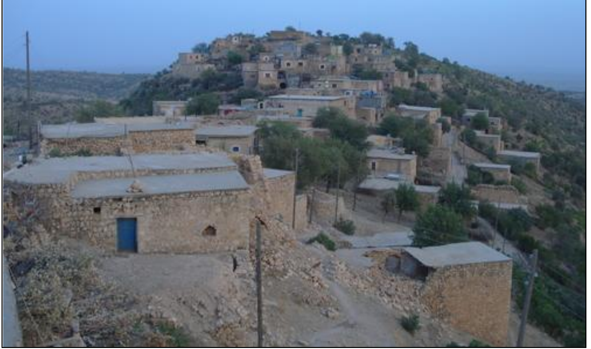
Foto 7: Ulaş Köyünde Taş Mesken Tipleri. İlçe Geneline En Yaygın Kullanılan Yapı Malzemesi Taştır. Daha çok tek katlı olarak inşa edilen meskenler iki katlı olarak da inşa edilebilmektedir.
