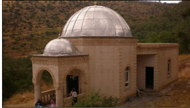
Foto 29: Kutlu Köyü Şeyh Hasan Türbesi
