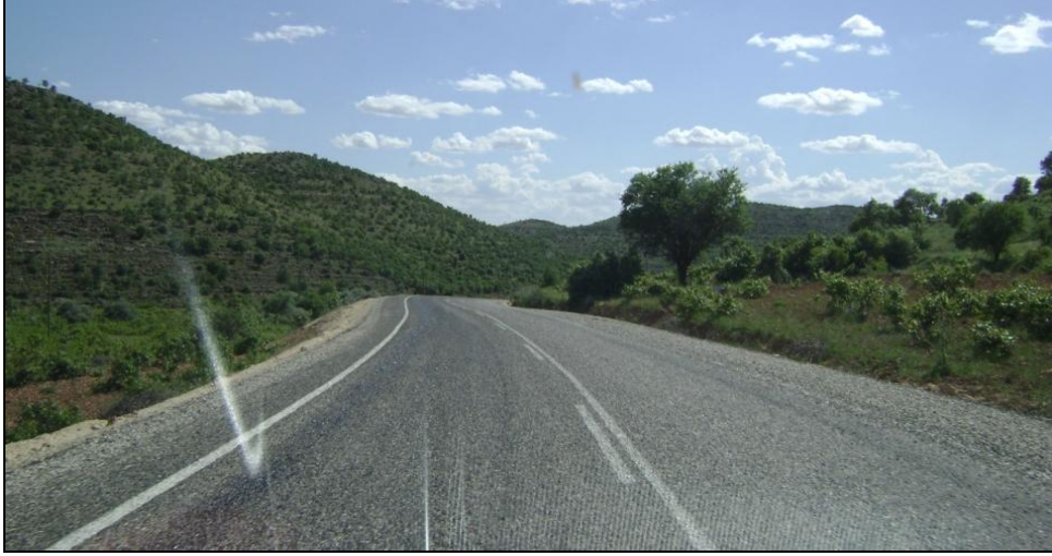
Foto 26: 2010 yılında yapımına başlanan ve devam eden Gercüş-Yemişli-Siirt Yolu. Gercüş'e bağlı 25 köy bu yoldan faydalanacaktır.
