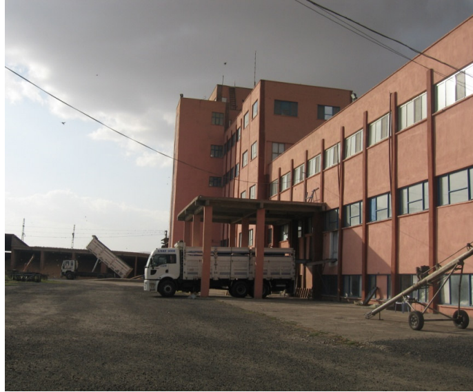
Foto 48: Ergani Gıda ve Un fabrikası
