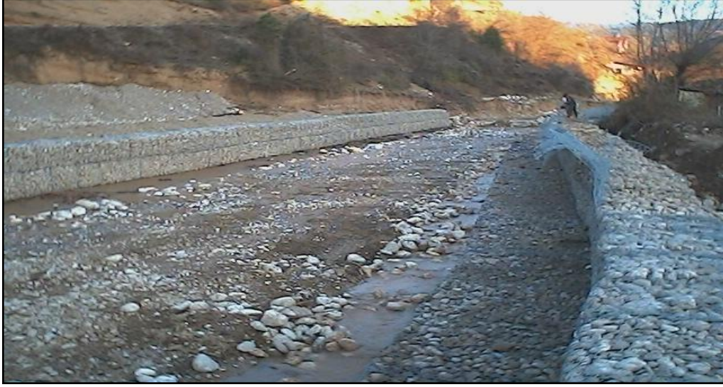
Şekil 2.20. Kıyı korumada kutu gabyon uygulaması
