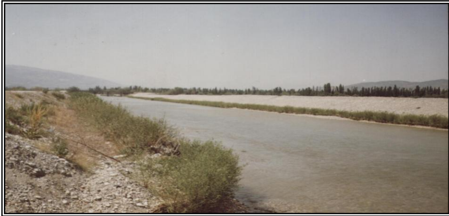
Şekil 2.25. Canlı iksa tahkimatından bir görünüm
