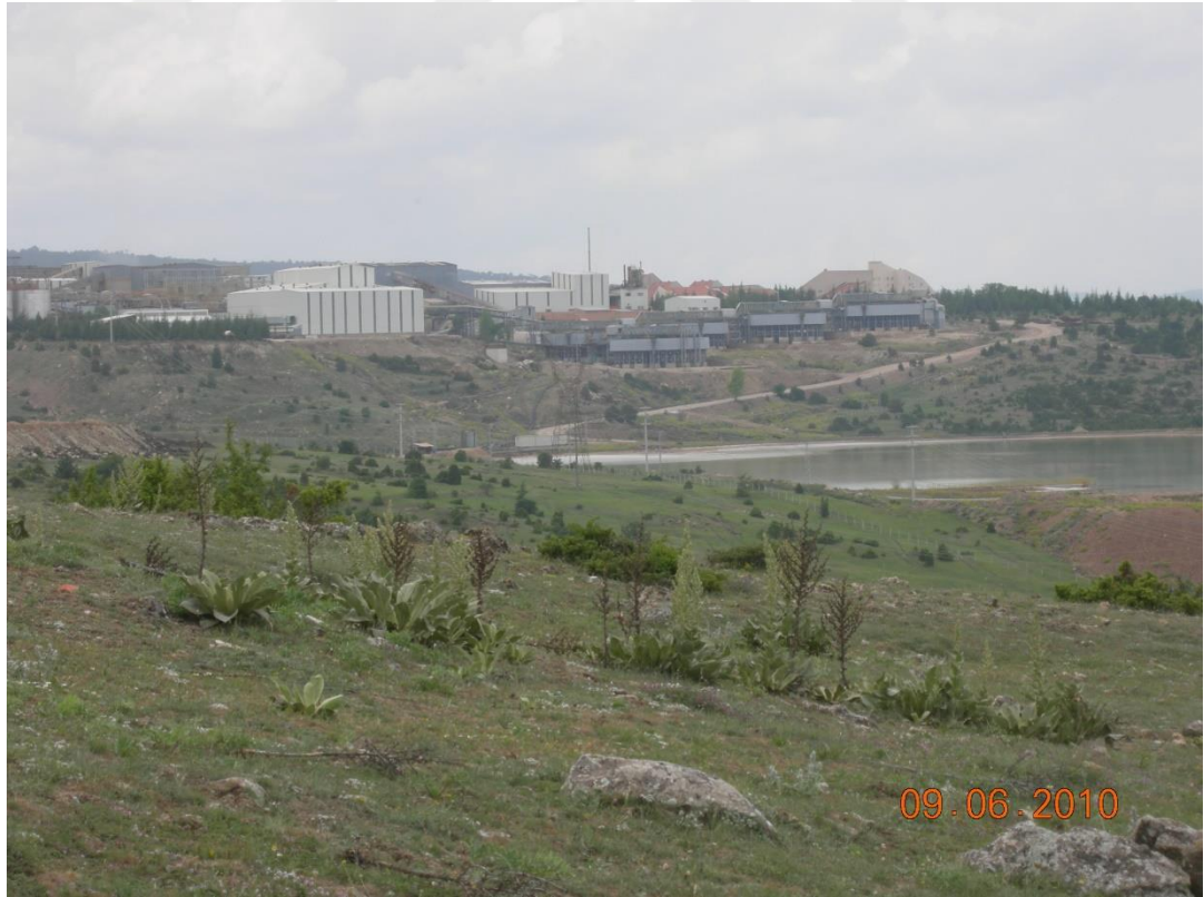
Şekil 1.6. Gümüşköy Ag işletmesi ve havuzların uzaktan görünüşü.
