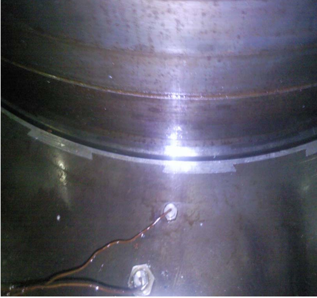
Şekil 3.46. Keban HES üniteleri türbin kılavuz yataklarının beyaz metalleri
