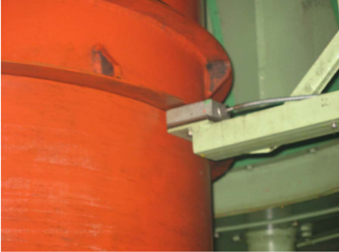
Şekil 2.10. Türbin kılavuz yatak salınım sensörü
