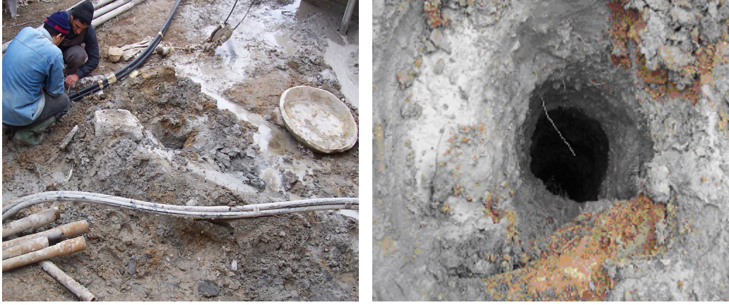
(a) (b) Şekil 3.14. 90 m'lik kuyunun a) kazı başlangıç ve b) kazı bitiş durumlarının görüntüleri
