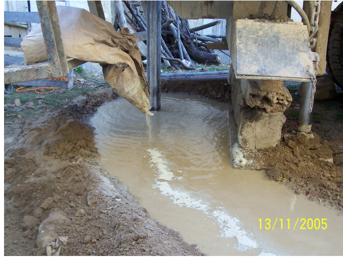
Şekil 3.10. Bentonitin çalışma suyuna eklenmesi
