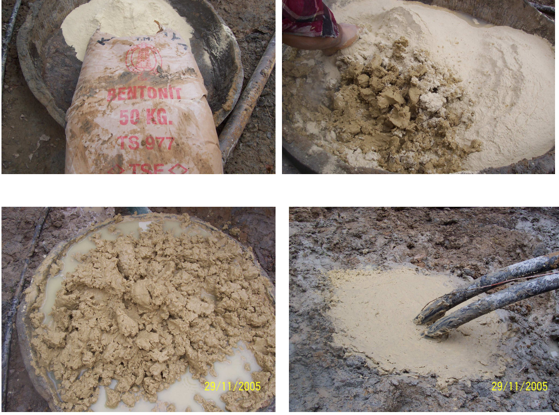
Şekil 3.22. Bentonitin hazırlanışı ve kuyulara doldurulması
