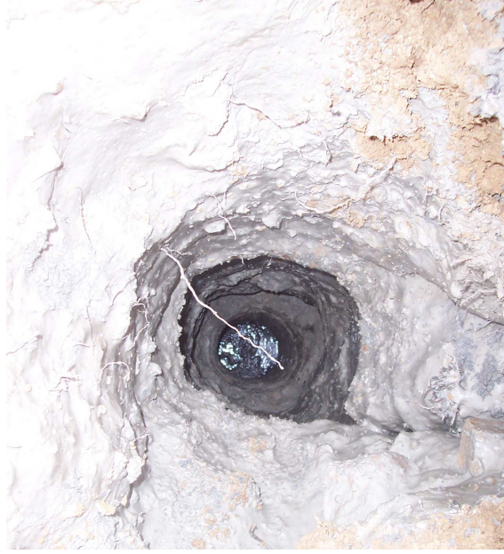
Şekil 3.21. Bentonitin kuyu içerisinde oluşturduğu duvarın görüntüsü
