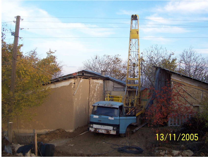
Şekil 3.8. Kazı aracının fotoğrafı
