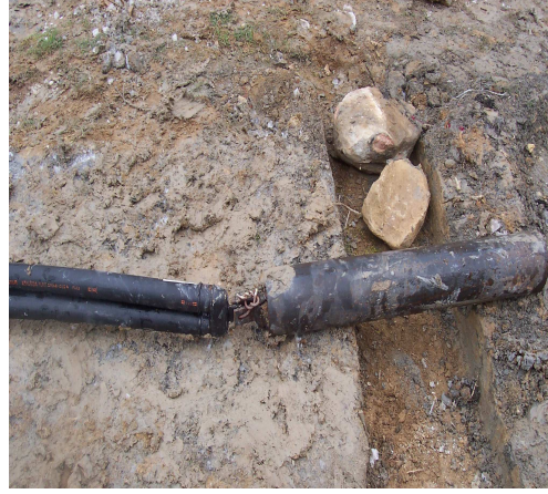
Şekil 3.17. U-borusuna bağlanan ağırlığın görünümü
