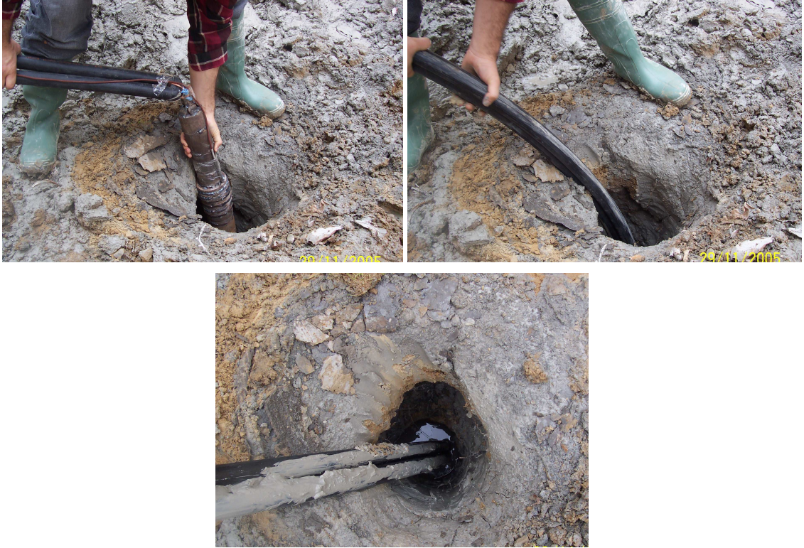
Şekil 3.20. Ucuna ağırlık takılan U-borusunun kuyuya bırakılmasının görüntüleri
