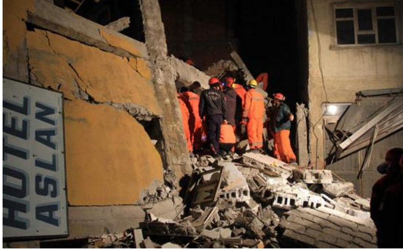
Şekil 6.3. Aslan otelin kuzey tarafından yıkılma durumu-2
