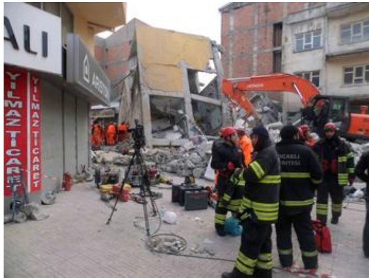
Şekil 6.2. Aslan otelin kuzey tarafından yıkılma durumu-1
