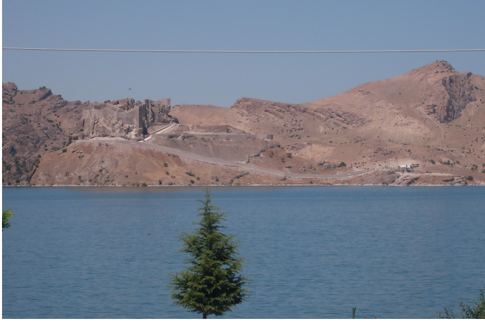
Fotoğraf 7: Restorasyondan Sonra Pertek Kalesinin Son Görünüşü
