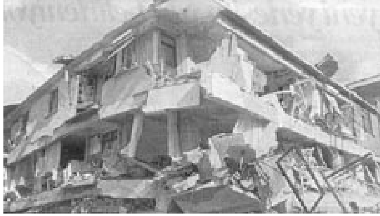
Şekil 2.1 17 Ağustos depreminde yıkılan bir yapının görünümü
