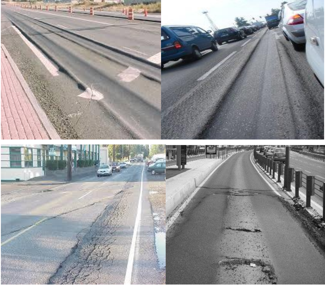
Şekil 5.1 Tekerlik izi deformasyonu
