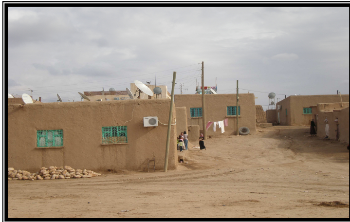
Foto 7: Fesliğin Köyünde Kerpiç Evlerden Bir Görünüm: Ova Köylerinde Ekseriya Yapı Malzemesi Topraktır. Araştırma alanımızda yapılan yeni meskenlerin neredeyse %90 tuğla veya biriket yapı malzemesi ile inşa edildiğini görmekteyiz.
