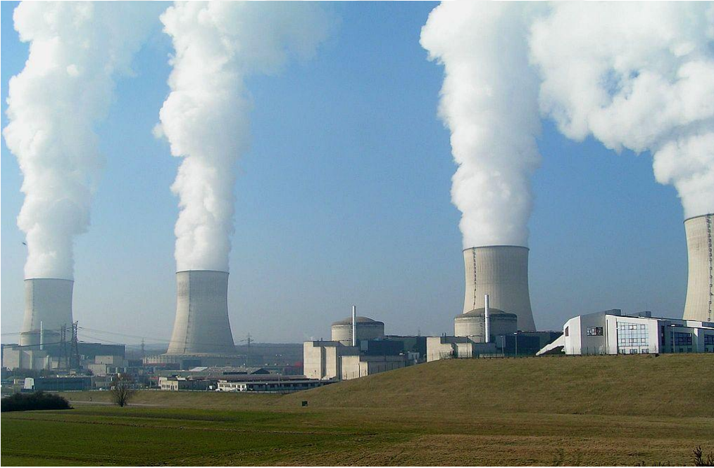
Fransa – Cattenom Nükleer Santrali (PWR), Santral deniz suyu ile soğutulmadığı için su kuleleri kullanılmaktadır.
