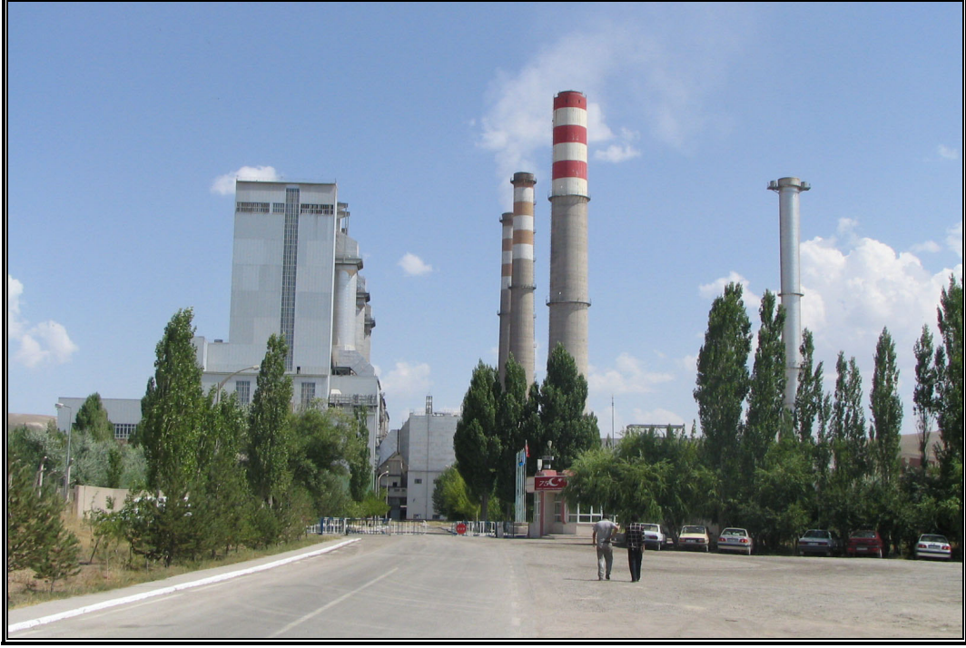
Foto 100: 300 MW kapasiteli Kangal Termik Santrali (Sivas)
