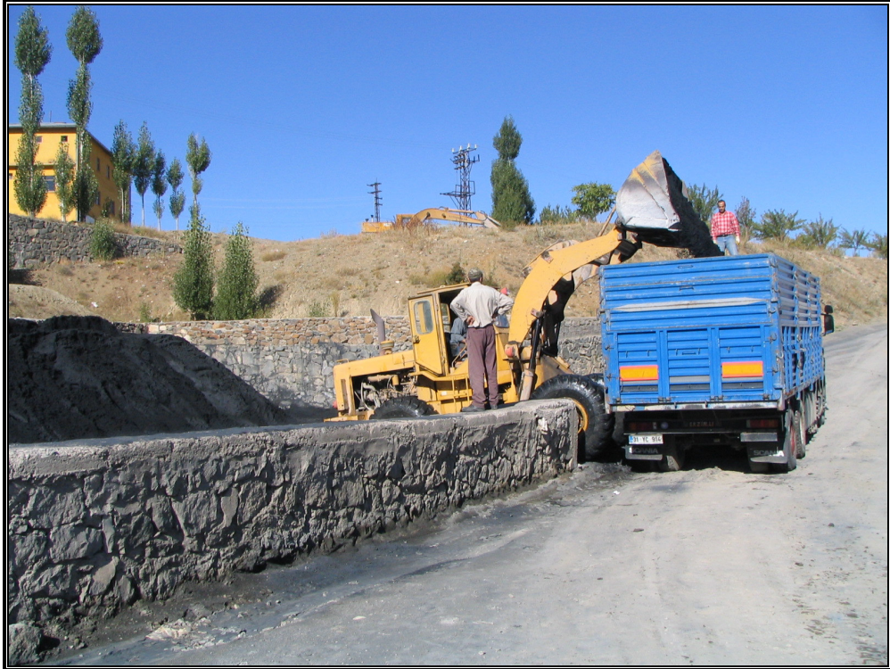
Foto 106: Bilfer A.Ş.'nin Eskiköy Krom Cevheri Zenginleştirme Tesisleri
