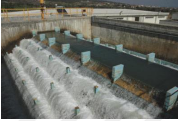
Şekil 2.8. Basamaklı kaskat örneği, Tahtalı İçme Suyu Arıtma Tesisi-İzmir
