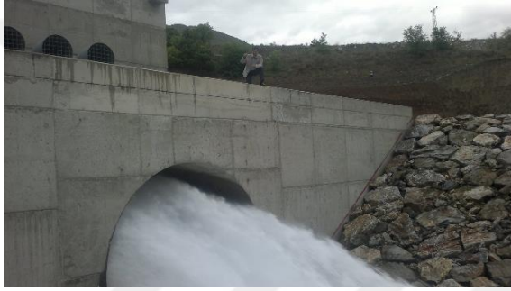
Şekil 2.15. Kuraklık nedeniyle açılan dipsavak örneđi, Adatepe Barajı- Kahramanmaraş / Afşin (2014)
