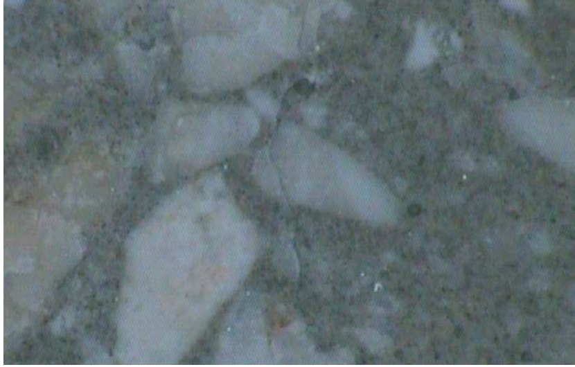
Şekil 7.14. R0 serisinden tespit edilen çatlakın genel görünüşü (20x)
