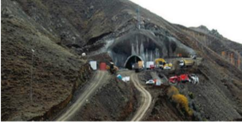
Şekil 6. Dallıkavak Tüneli, Erzurum-İspir Arası
