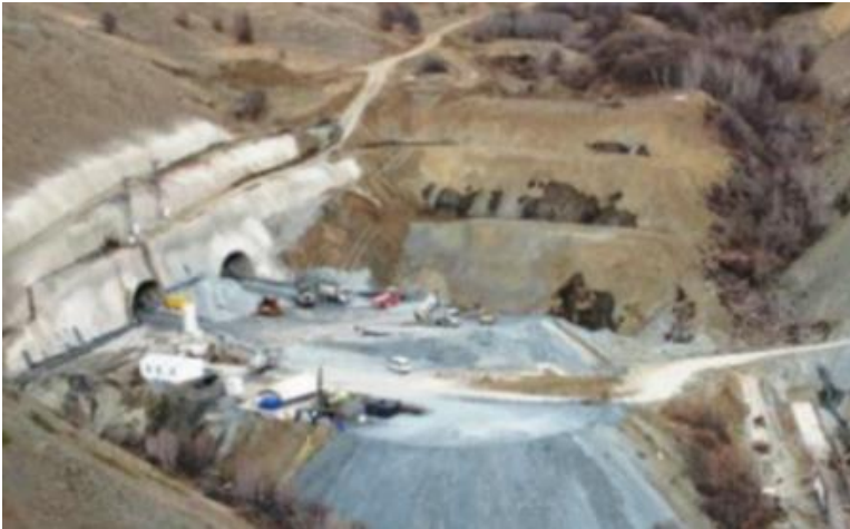
Şekil 5. Kop Tüneli, Erzurum-Bayburt Arası
