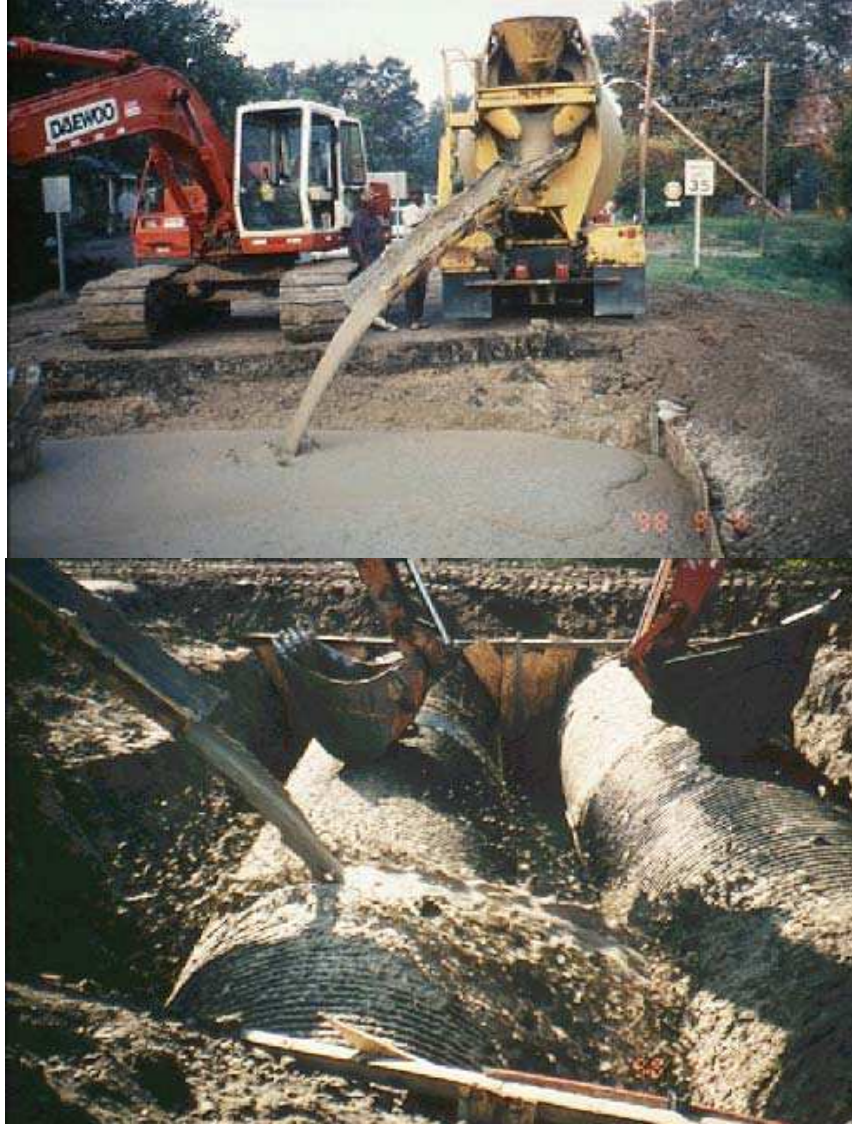
Şekil 1.3 Kontrollü Düşük Dayanımlı KYB Uygulamaları
