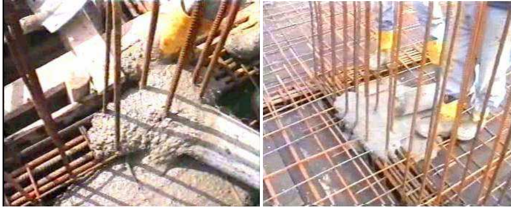
Şekil 1.7 Dar Donatılı Kesitlerde KYB Uygulaması
