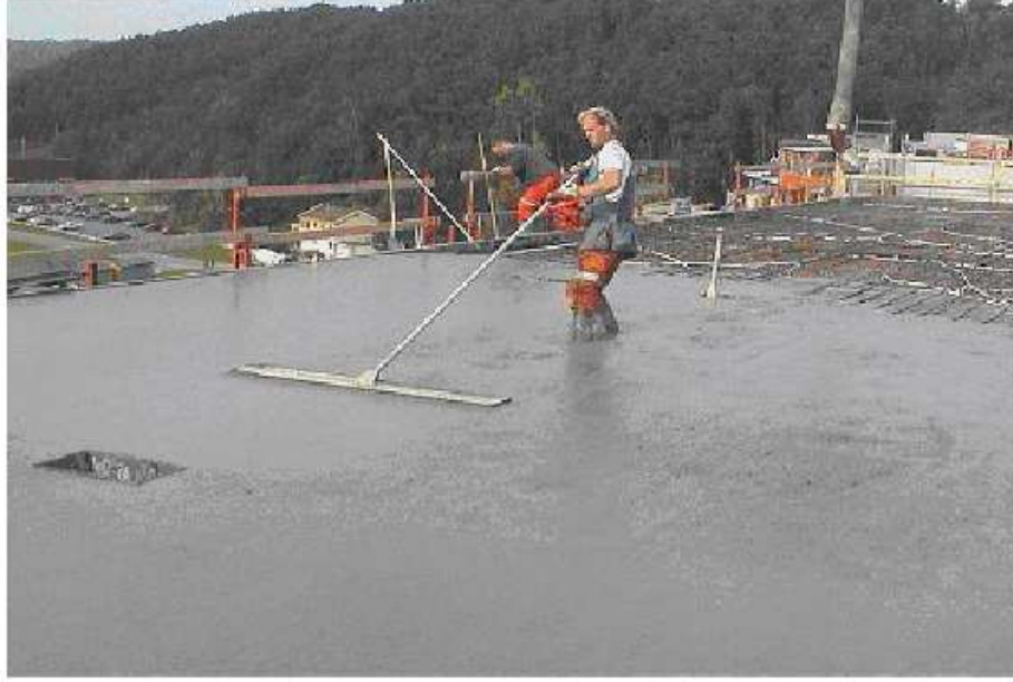
Şekil 1.8 KYB' nin Perdahlanması
