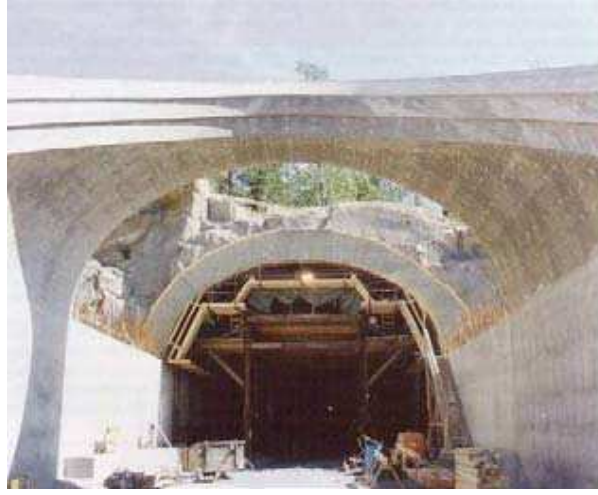
Şekil 1.2 İsveç Stockholm'de KYB Kaplanmış Bir Tünel
