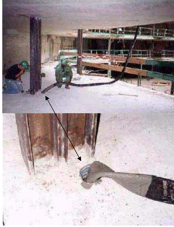
Şekil 1.1 Kendiliğinden Yerleşen Beton Uygulaması
