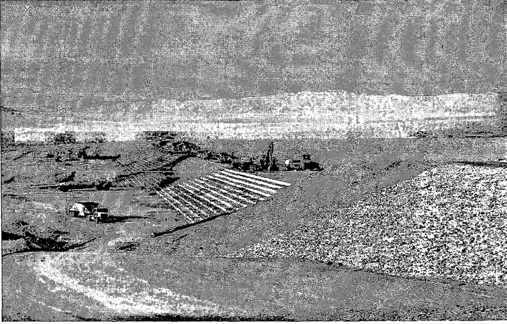
Şekil 3.3. Wolwedans RCC baraj inşaatı -LASVEGAS
