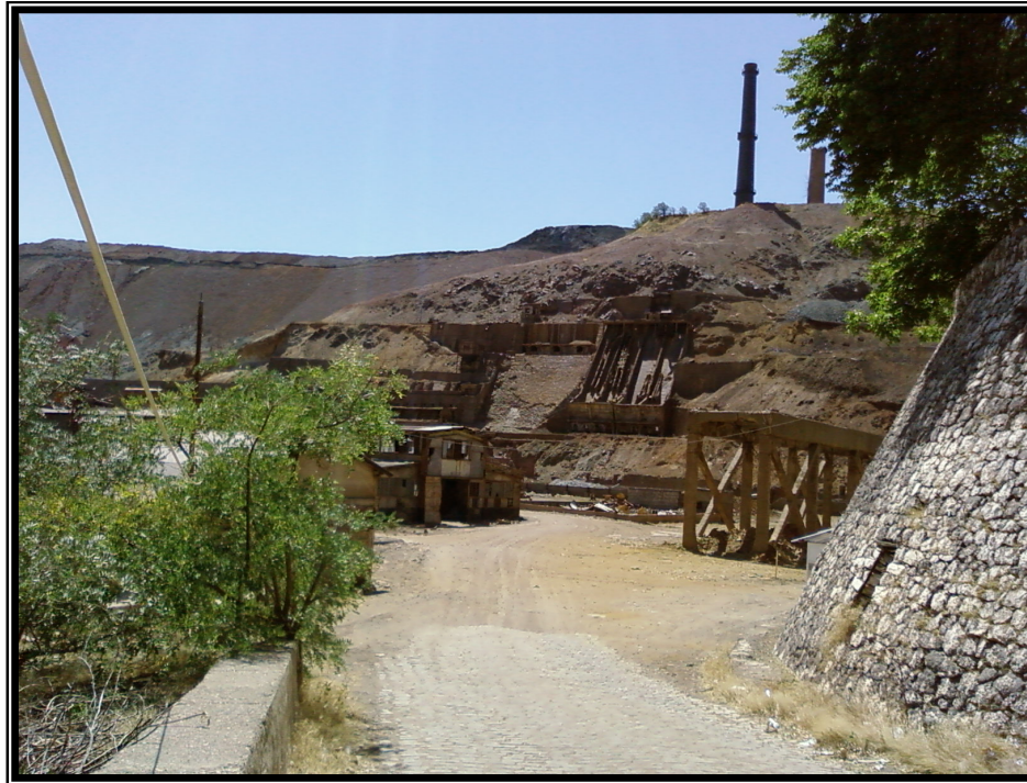
Resim 29 – EBİ’nin nizamiye girişinden bir görünüm
