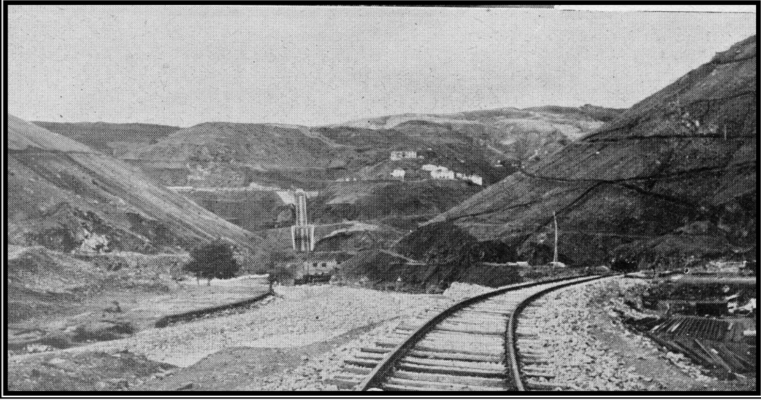
Resim 32 – İstasyondan işletmeye giden demiryolu ve yapılan asansörün uzaktan görünümü ( Bayındırlık İşleri Dergisi 'nden alınmıştır.)
