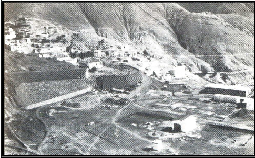
Resim 31 – Ergani Bakır İşletmesi’nin kuruluş yılları (Nizamiye girişi gösterilmekte) (Maden 1986 İlçe Yıllığı adlı eserden alınmıştır.)
