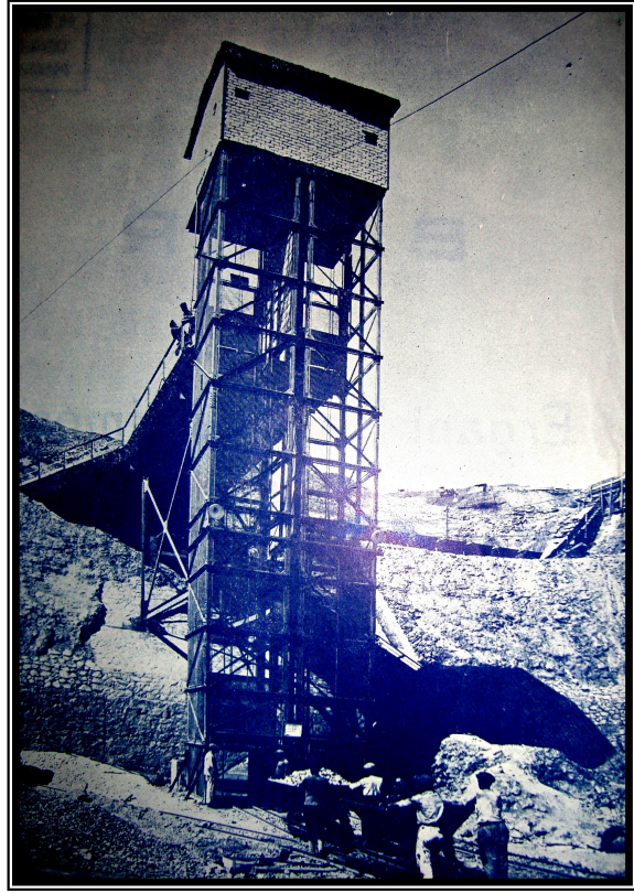
Resim 5 – Vagonların taşınması için yaptırılan asansör (Bakır 1949 adlı eserden alınmıştır.)
