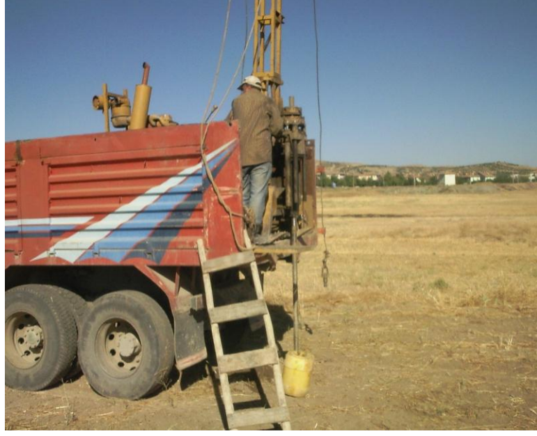
Şekil 3.11. 9 nolu temel sondaj çalışmasını gösteren fotoğraf
