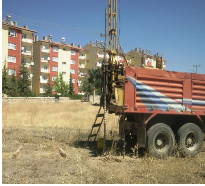
Şekil 3.9. 8 nolu temel sondaj çalışmasını gösteren fotoğraf
