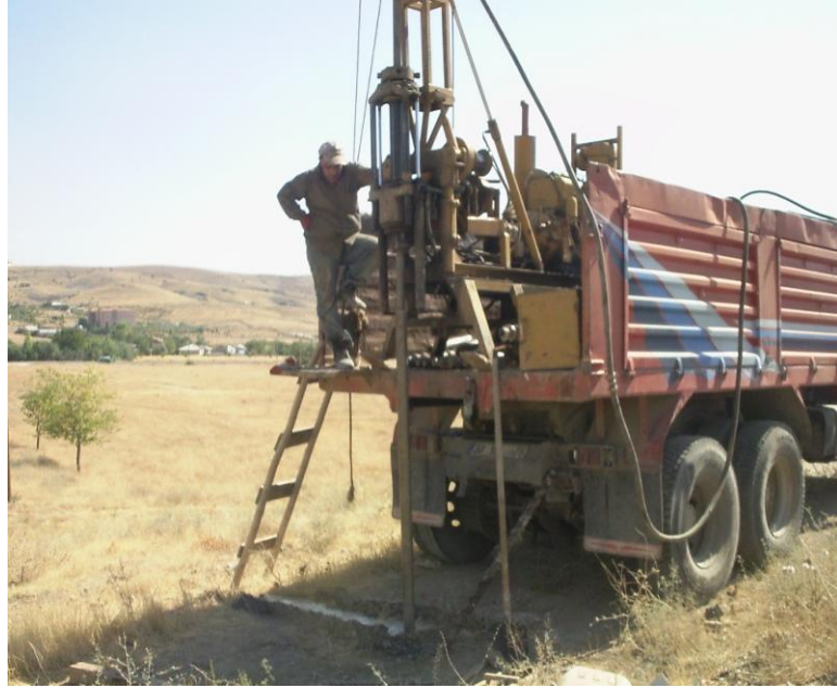
Şekil 3.18. 16 nolu temel sondaj çalışmasını gösteren fotoğraf
