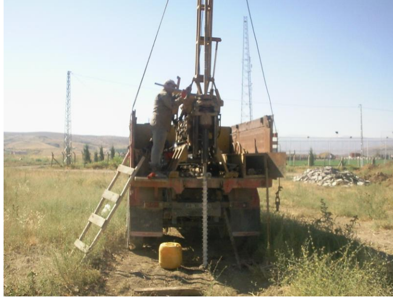
Şekil 3.15. 13 nolu temel sondaj çalışmasını gösteren fotoğraf
