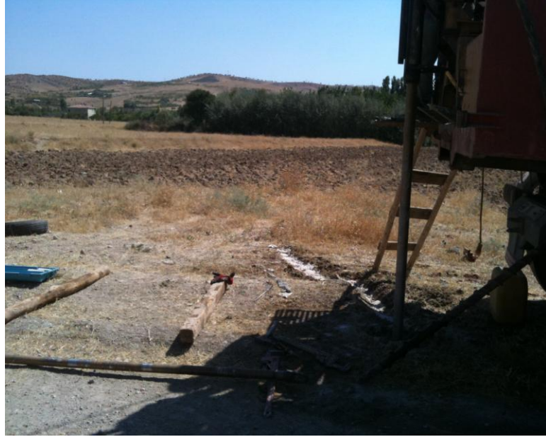
Şekil 3.16. 14 nolu temel sondaj çalışmasını gösteren fotoğraf
