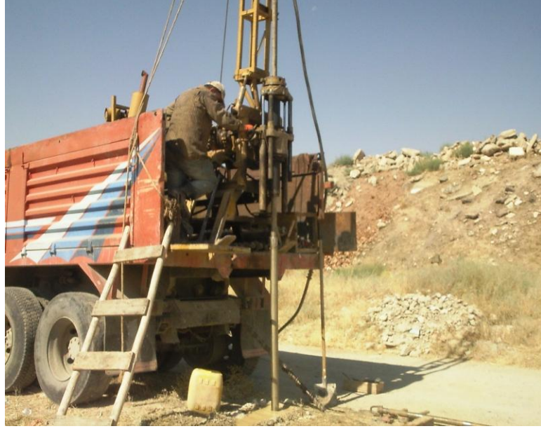
Şekil 3.17. 15 nolu temel sondaj çalışmasını gösteren fotoğraf
