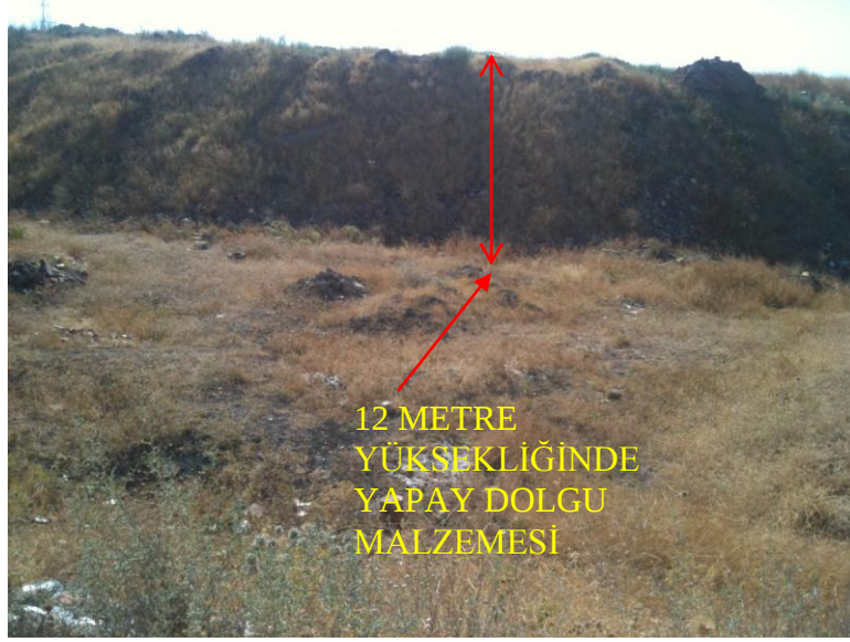
Şekil 3.22. Dolgu malzemesi yüksekliğini gösteren fotoğraf
