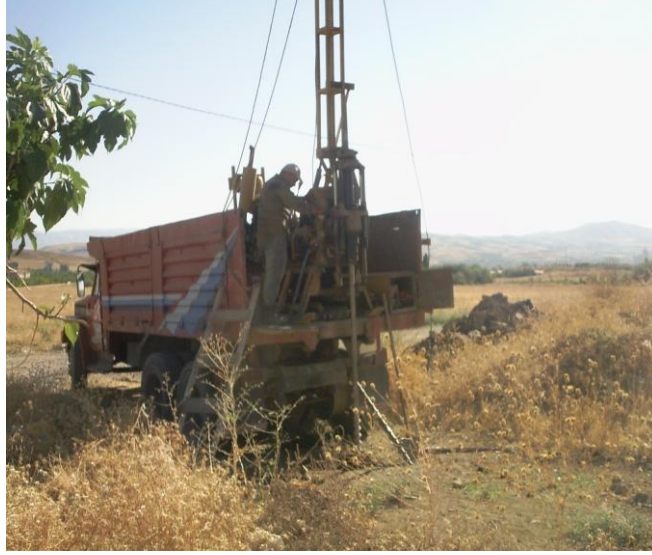
Şekil 3.1. 1 nolu temel sondaj çalışmasını gösteren fotoğraf
