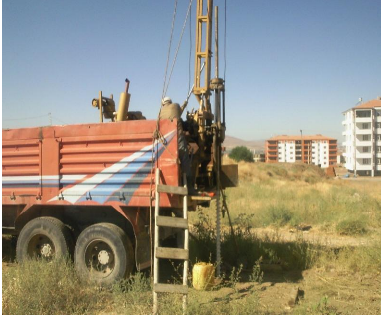
Şekil 3.13. 11 nolu temel sondaj çalışmasını gösteren fotoğraf
