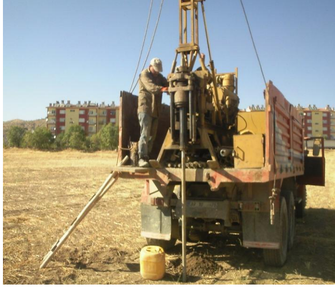
Şekil 3.7. 6 nolu temel sondaj çalışmasını gösteren fotoğraf
