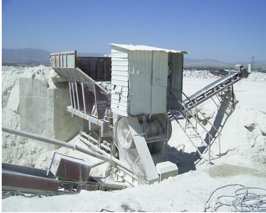
Şekil 2.2. Hammadde depo sahası ve yatay kırıcı
