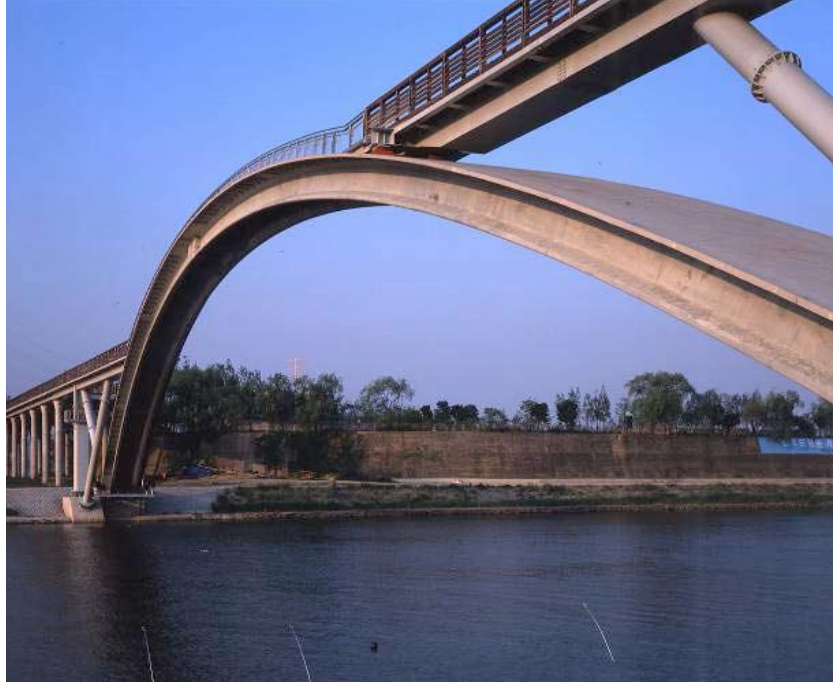
Şekil 2.7. Kore’de bulunan, açıklığı 120 m ve kemer yüksekliği 130 m olan Köprü (Mehta ve Monteiro, 2006).
