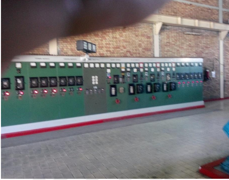
Resim 7. Fueloil ile üretilen elektrikle çalışan elektrik trafosu
