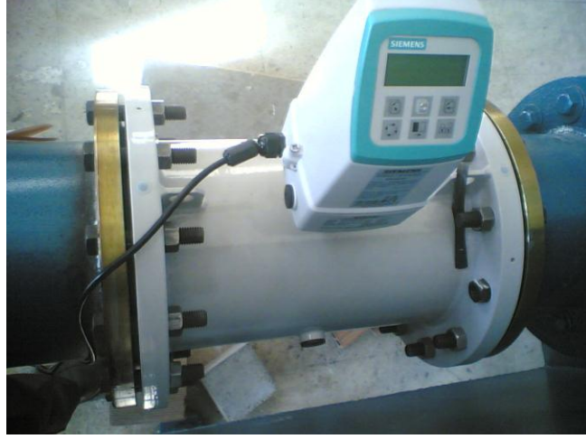
Şekil 3.5.. Giriş debisini ölçen elektromanyetik debimetre
