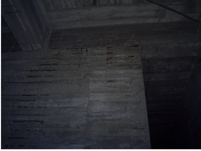
Fotoğraf 4.8. Kötü Kalıp İşçiliği ve Açığa Çıkan Donatılar-4
