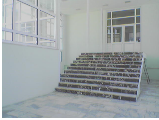
Fotoğraf 4.19. Hiçbir Doğal Havalandırması Olmayan PVC Doğramalar
