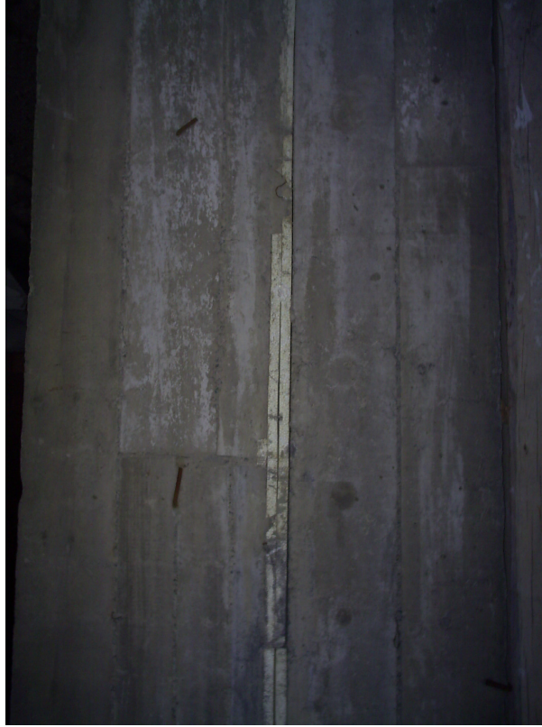
Fotoğraf 4.4. P2-O Bloğu'nda Uygulanmakta Olan Dilatasyon Derzi
