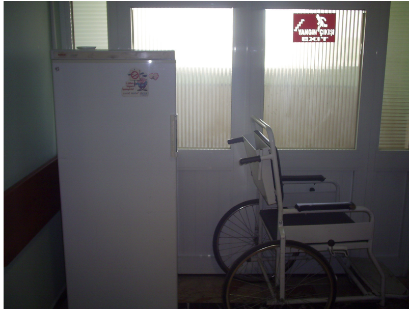
Fotoğraf 4.13. Kapı Önü Kapatılmış PVC Doğramalı Yangın Çıkış
