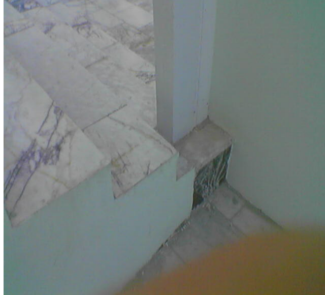
Fotoğraf 4.20. Kol Genişliği Duvar Tarafından Kesilen Merdiven
