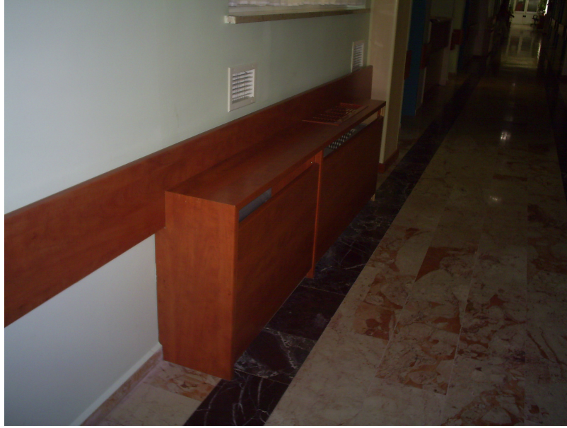
Fotoğraf 4.14. Merkezi Havalandırma Sistemi ve Lokal Klimalar
