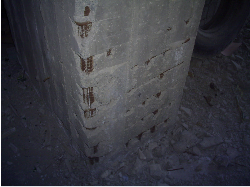
Fotoğraf 4.8. Kötü Kalıp İşçiliği ve Açığa Çıkan Donatılar-4
