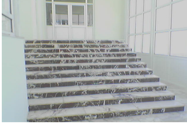
Fotoğraf 4.20. Kol Genişliği Duvar Tarafından Kesilen Merdiven
