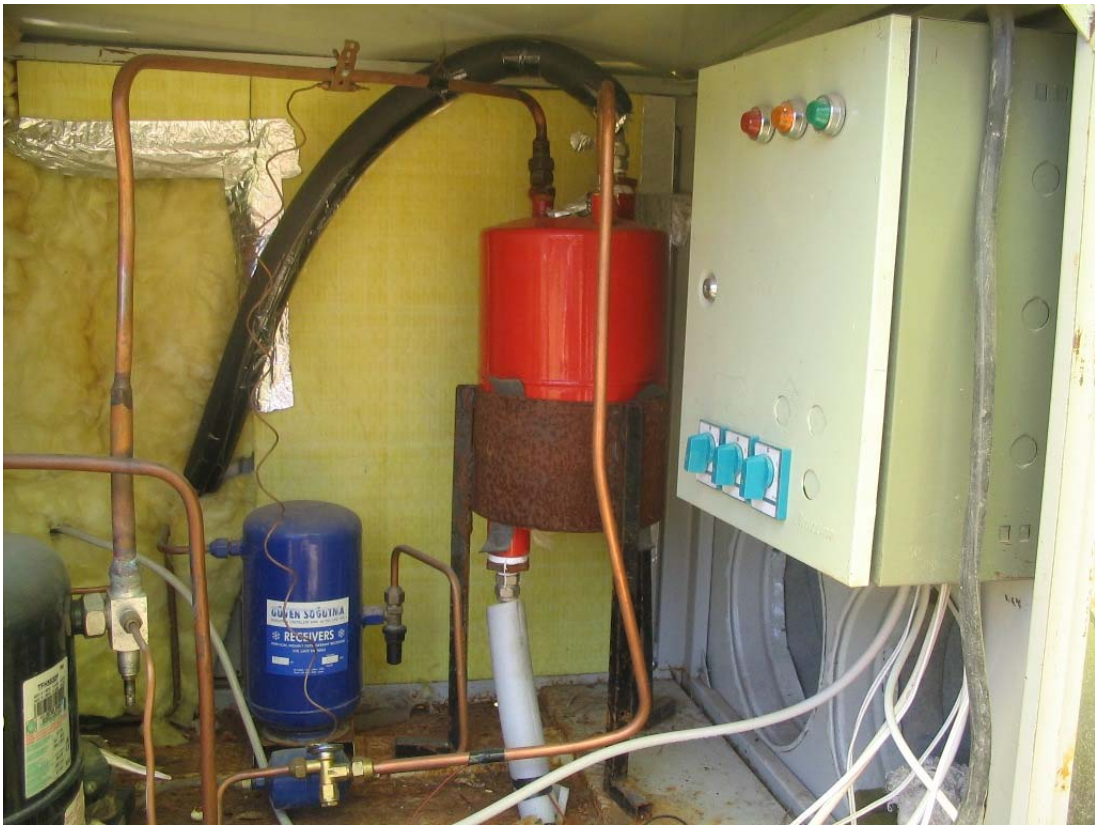
Şekil 3.12 Silindirik İç İçe Borulu Isı Eşanjörünün Görünüşü
