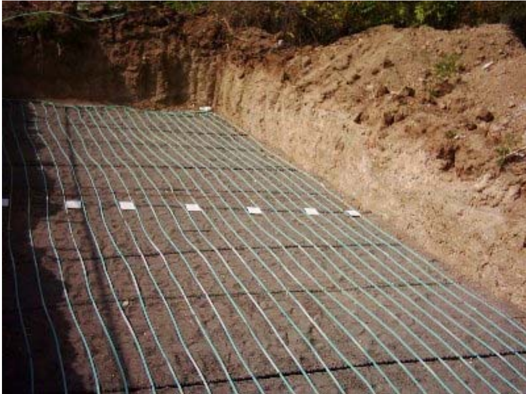
řekil 3.19 Toprak Altı Isı Deėiřtiricisi ve Hortumların Görünüřü.
