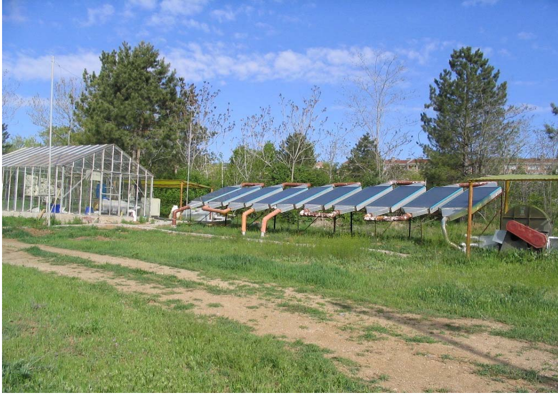
Şekil 3.24 Seranın Komple Görünüşü
