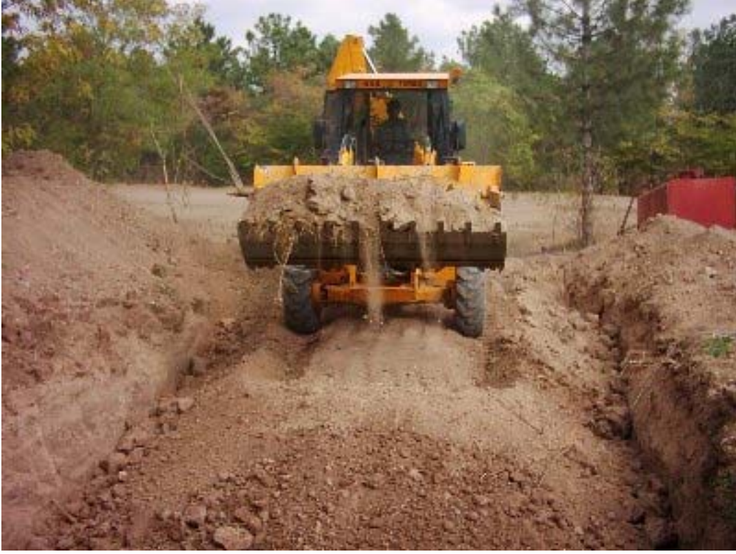
Şekil 3.21 Zeminin Toprakla Kapatılması
