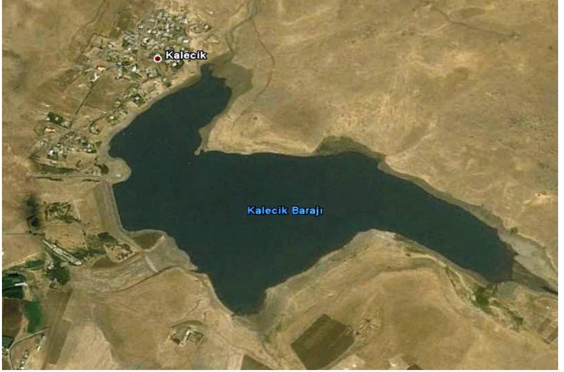
Şekil 2.1.1. Kalecik Baraj Gölü'nün üstten görünüşü
