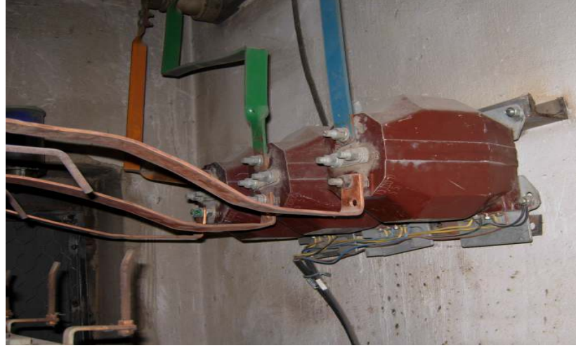
Şekil 2.1 MC20-R Röleye Akım Trafosundan Bilgi Aktarılması
