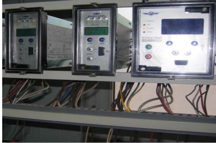
Şekil 2.10 MC20-R ve FMR tip rölelerden oluşan bilgi toplama sistemi
