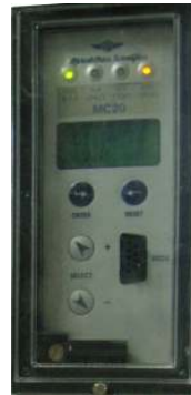
Şekil 2.9 MC20-R Tip aşırı akım ve toprak kaçağı rölesi
