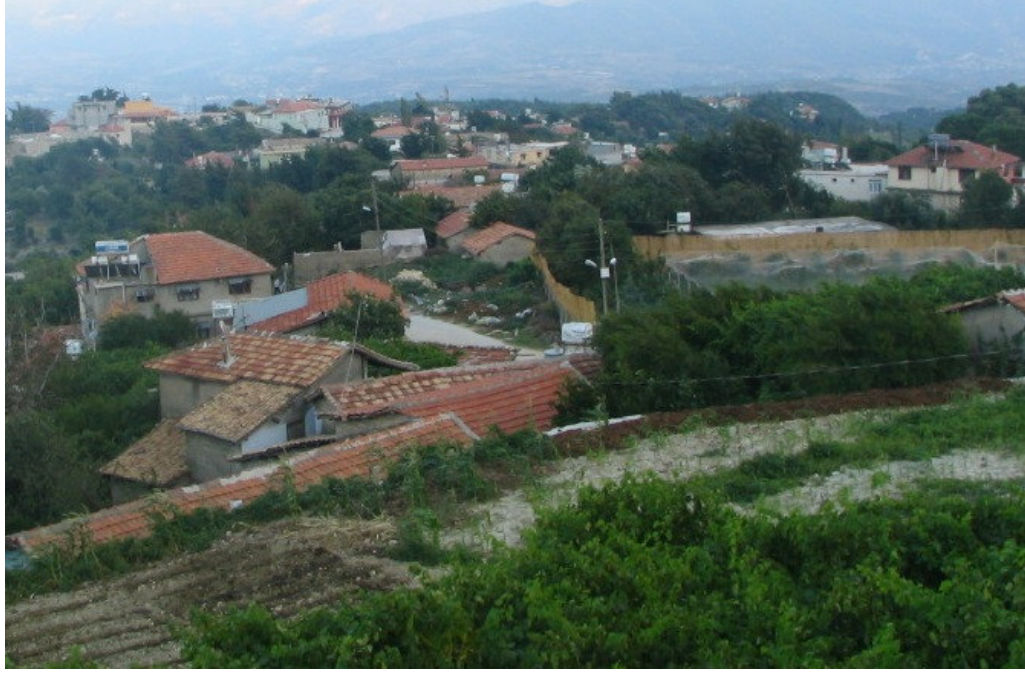
Foto 14: Samandağ ilçesinde çatı sisteminde değişiklikler yaşanmaktadır. Batıayaz köyündeki gibi eski konutlarda kiremit beşik çatılar yoğunluktadır.
