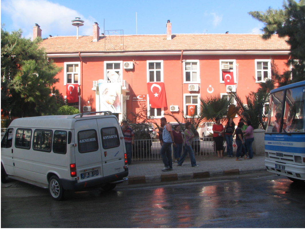
Foto 21: Samandağ hükümet konağı içerisinde kaymakamlık, adliye, nüfus müdürlüğü, tapu müdürlüğü, kadastro şefliği, tarım müdürlüğü bulunmaktadır.
