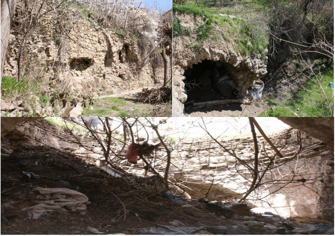
Fotoğraf 18. Hamamdan Kalan Yıkıntılar
