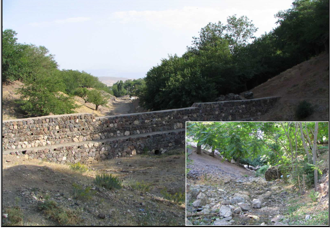
Foto 158: Harput Platosu'ndan Elazığ Ovasına inen pek çok derenin (Ulukent deresi gibi) önüne setler yapılmış olmasına karşılık, Harput platosundan kuzeydeki Keban Baraj Gölü'ne dökülen akarsuların yatağında, gelen sedimenti engellemek için bu gibi tedbirler alınmamıştır.
