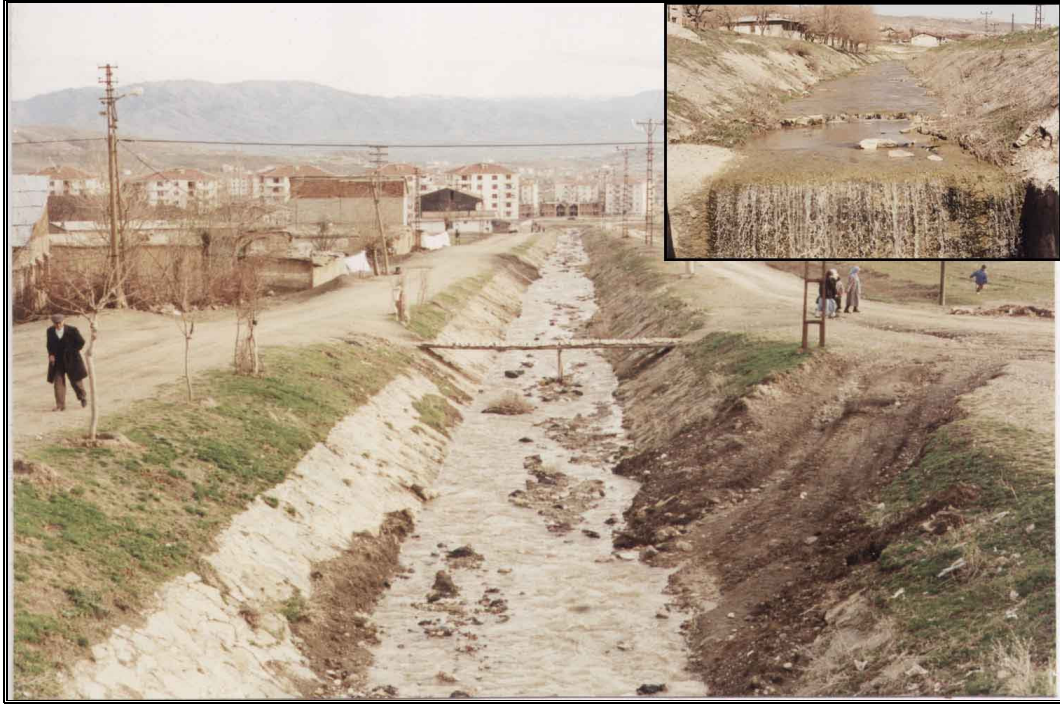
Foto 39: 1962 yılında, Harput Platosu'ndan inen sel karakterdeki akarsuların tehlikesinden Elazığ Şehrini korumak amacıyla yapılan kuşaklama kanalı.
