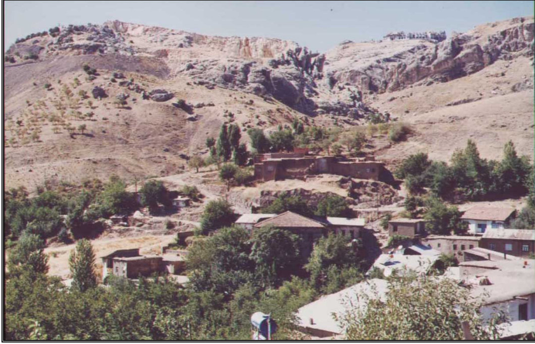
Foto 131: Ulukent mahallesinin kuzeyindeki Harami formasyonuna ait kalkerlerden oluşan bloklardan zaman zaman kayalar kopmakta ve Ulukent(Hüseyinik) mahallesine kadar yuvarlanmaktadır.
