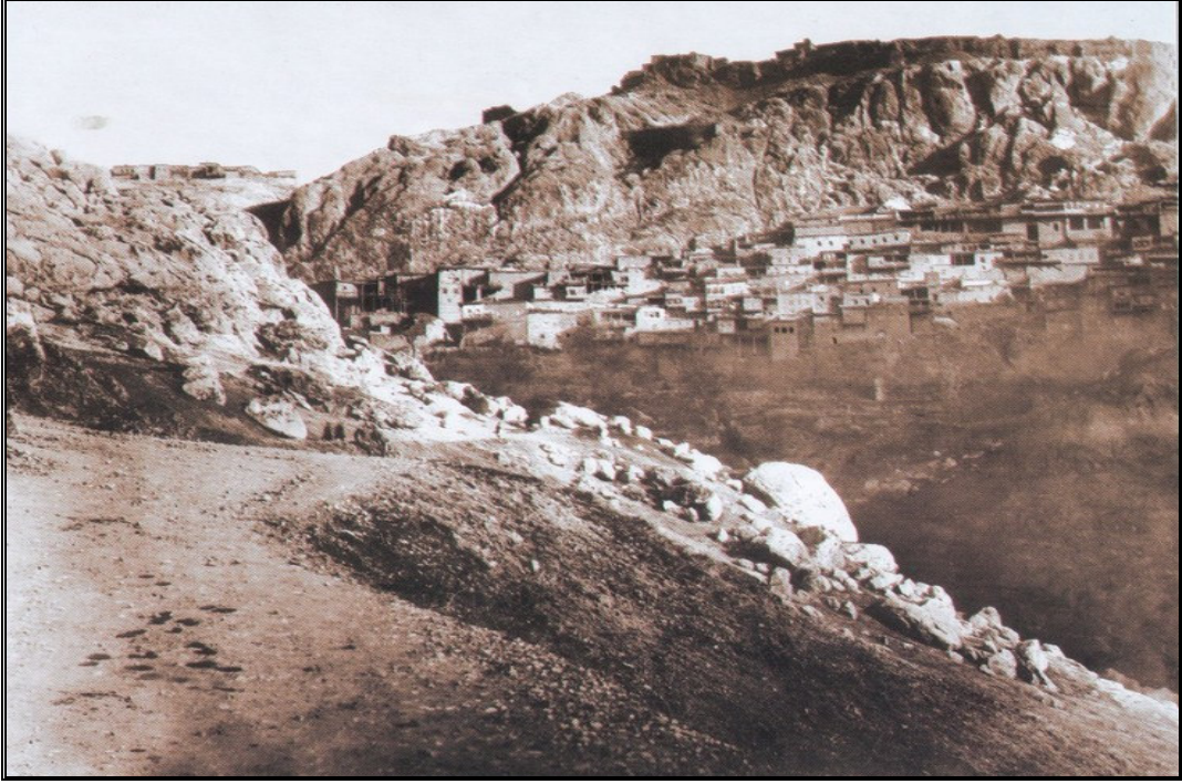
Foto 127: Harput Kalesi'nden kopan kaya bloğu 29 Haziran 1898 tarihinde Sinabut mahallesine düşmüştür(ELGİAD 2002, Anılardaki Elazığ 1 albümünden alınmıştır)
