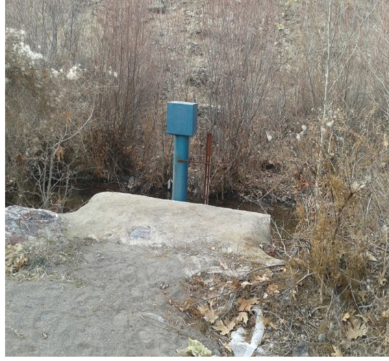
Şekil 2. I. İstasyondaki DSİ akım ölçüm istasyonu
