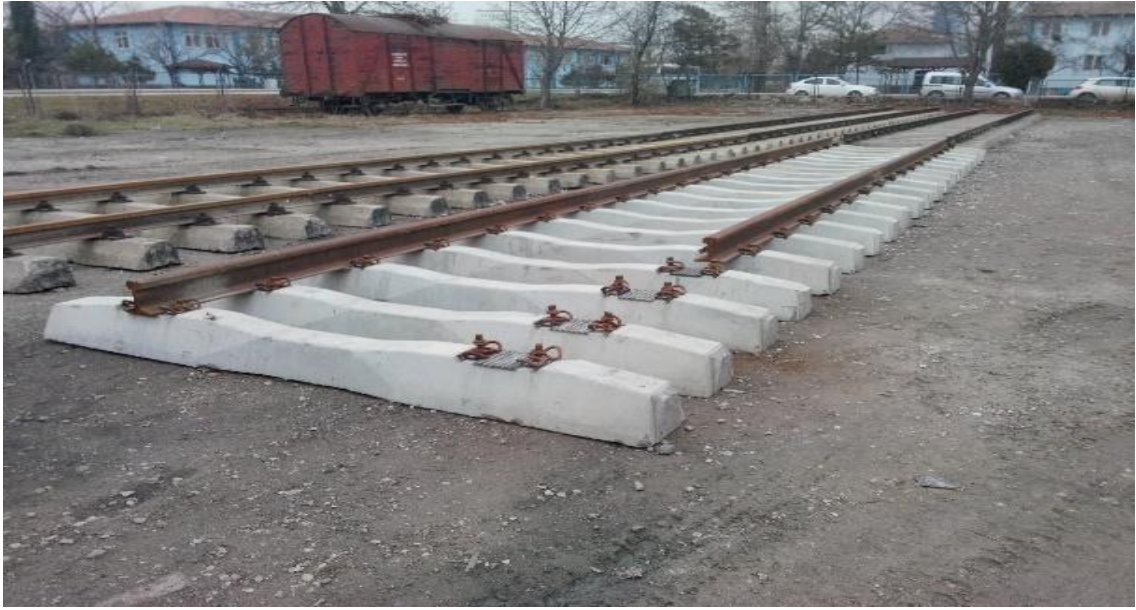
Şekil 2.1. S49 çelikleri kullanılarak yapılan bir demiryolu ve ray sistemi
