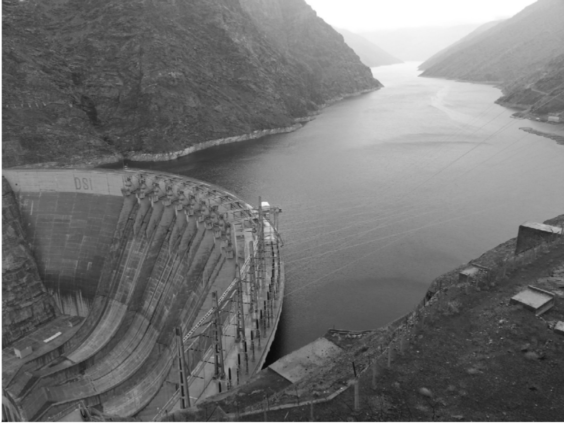
Şekil 3.15. Karakaya hidroelektrik santrali ve baraj gölünden bir görünüş
