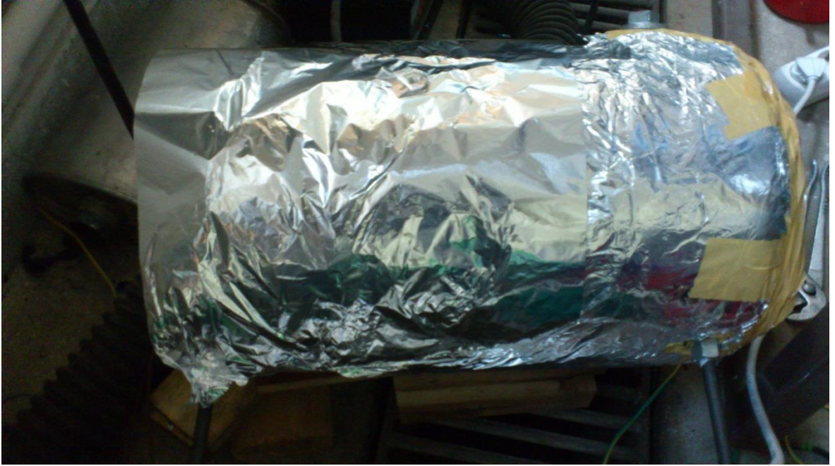
Şekil 4.9. Yalıtımı yapılırken termal enerji depolama tankı
