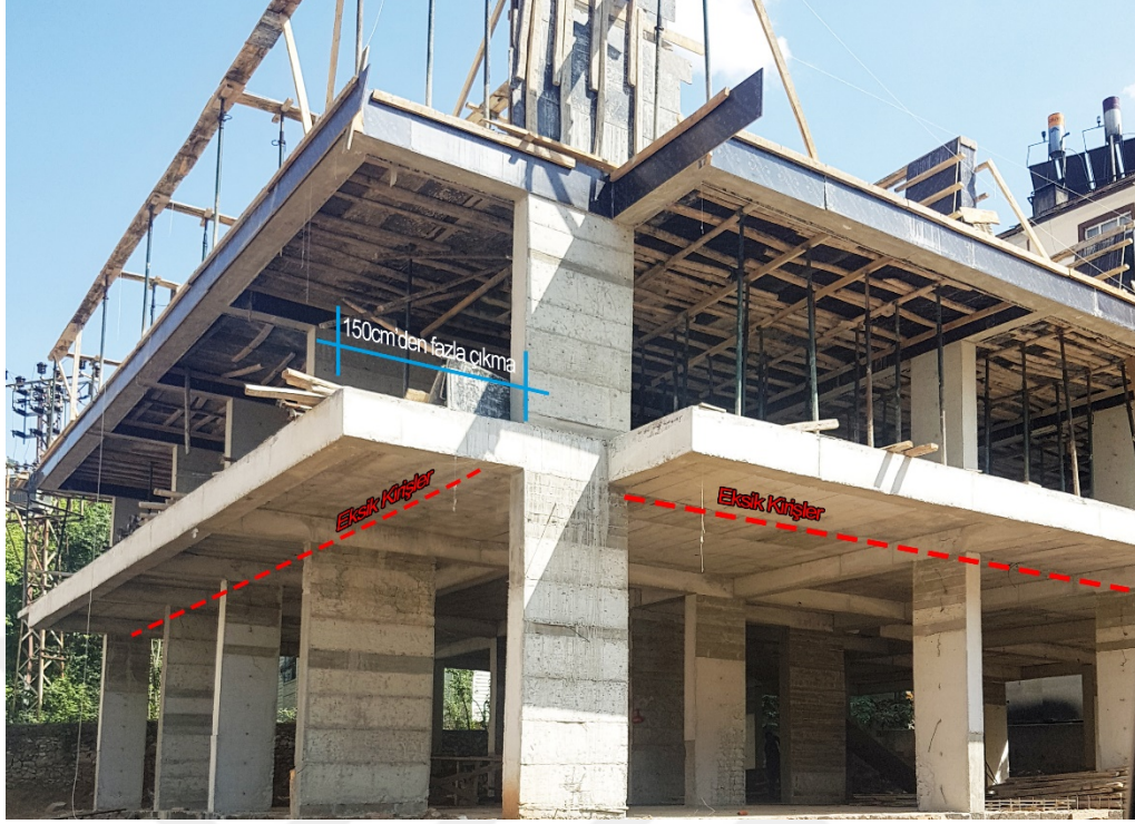
Şekil 2.8. Planda çıkmalı ve süreksiz kiriş yapısına ait inşaat uygulaması örneği
