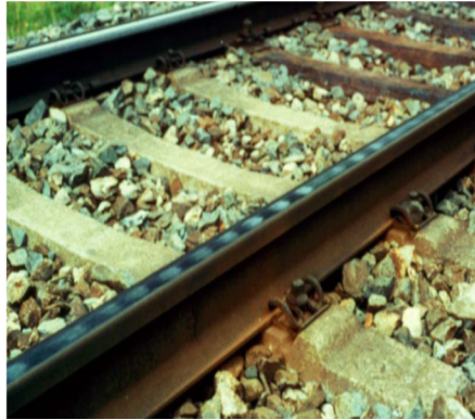
Şekil 2.3. Ondülasyon Arızası
