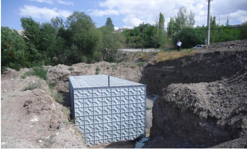
Şekil 6.60. Kemah İlçesi Paket Arıtma Ünitesi
