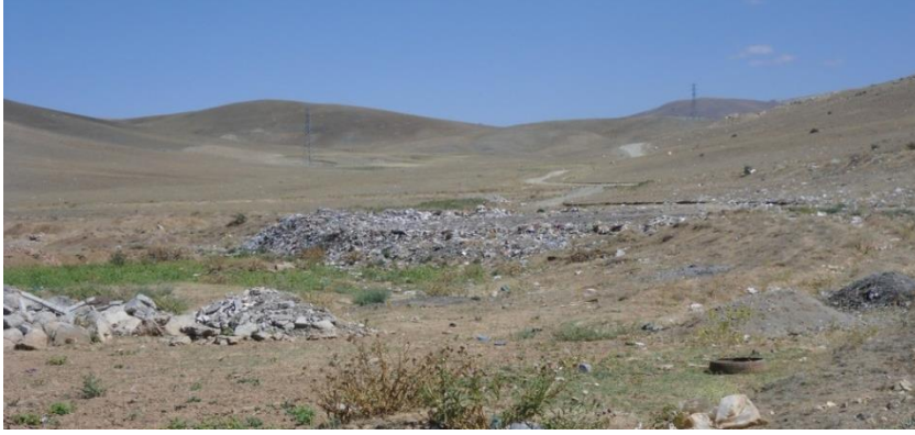
Şekil 6.55. Çadırkaya Beldesi Katı Atık Depolama Sahası
