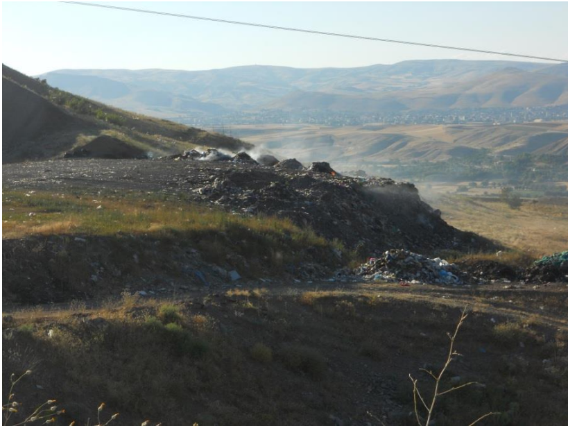
Şekil 6.23. Palu İlçesi Katı Atık Depolama Sahası
