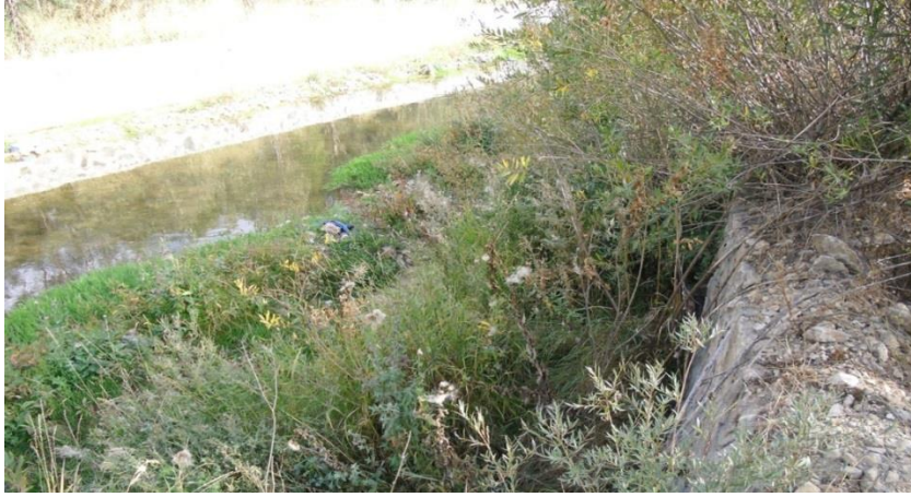
Şekil 6.58. Refahiye İlçesi Evsel Atıksu Deşarj Noktası
