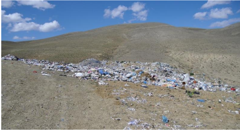
Şekil 6.53. Ulalar Beldesi Katı Atık Depolama Sahası
