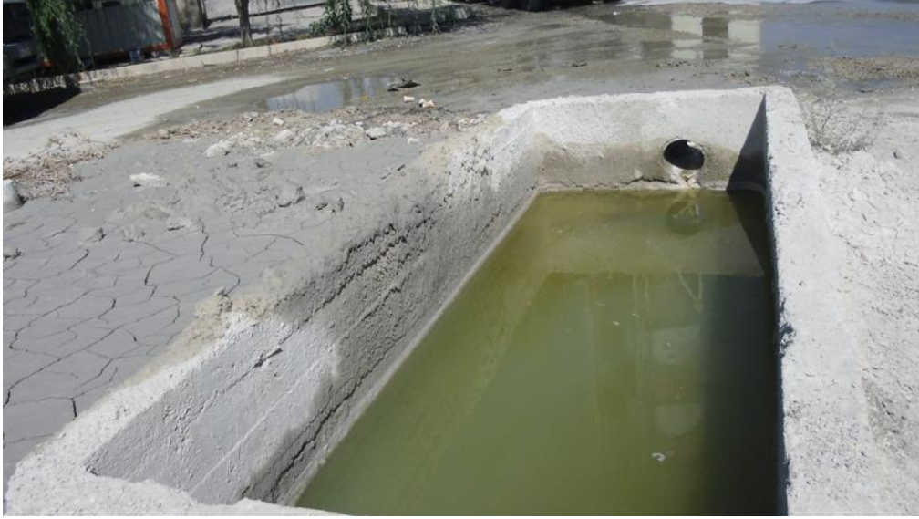
Şekil 6. 67. Erzincan Teknik Hazır Beton Santrali Çökeltme Havuzu
