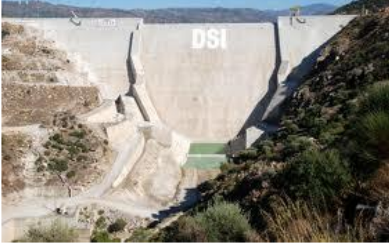
Şekil 2.8. Çine Barajı Basamaklı Dolusavağı
