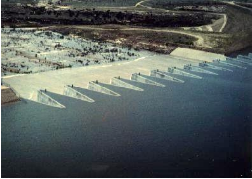
Şekil 2.6. Ute Barajı Labirent Dolusavağı
