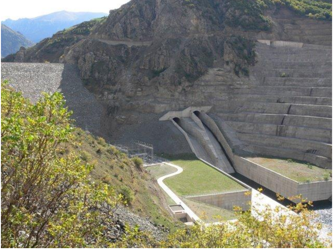
Şekil 2.5. Kürtün Barajı Tünelli Dolusavağı
