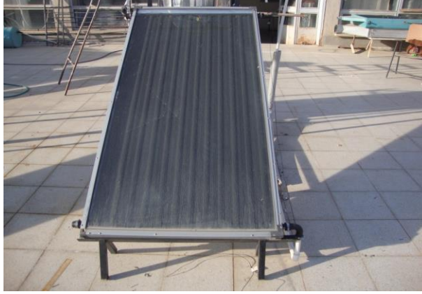
Şekil 2.2. Düzlemsel yüzeyli güneş kollektörü
