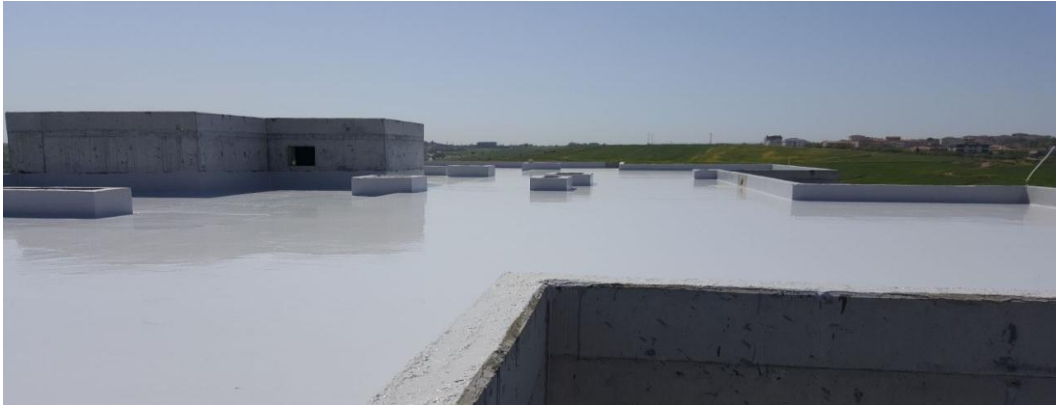
Şekil 3.9. Poliüretan esaslı sürme yalıtım uygulaması – Nidapark-Kayaşehir / İstanbul
