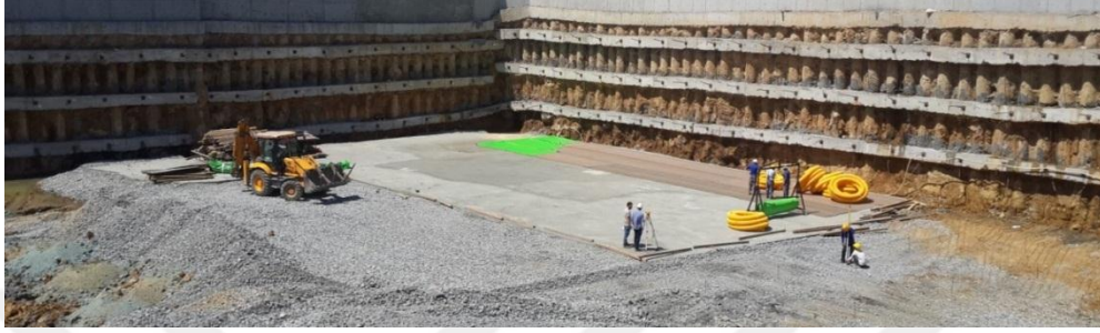
Şekil 3.6. Bentonit esaslı geomembran uygulaması - 34 İnn projesi İstanbul
