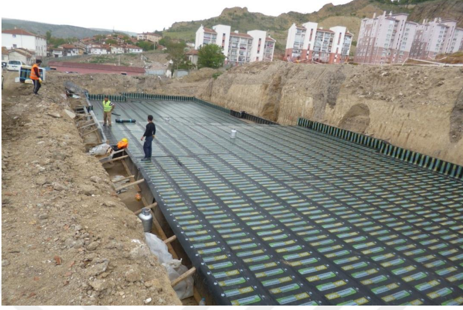
Şekil 3.2. Polimer bitümlü membran uygulaması (URL-9,2018).
