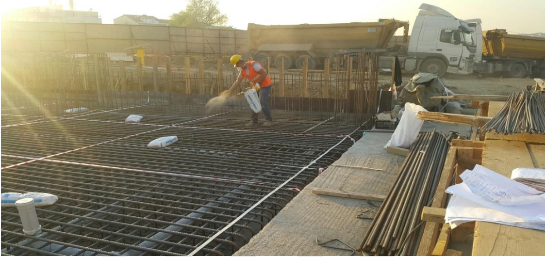
Şekil 4.18. Katkı malzemesinin serpiştirilerek uygulaması
