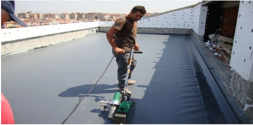
Şekil 3.3. PVC membran uygulaması (URL-10,2018).
