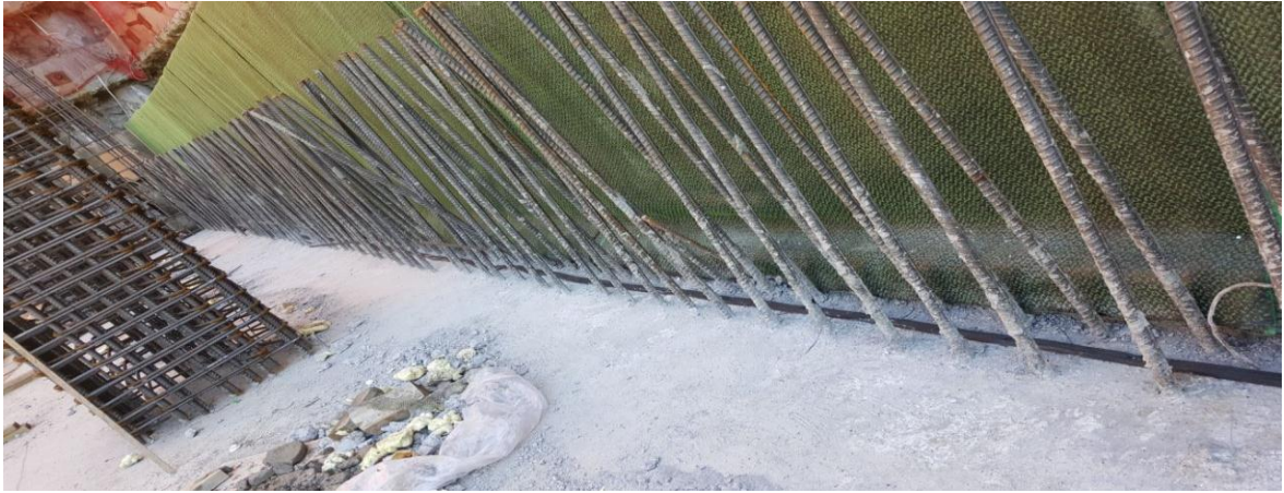
Şekil 4.13. Temel perde birleşimi şişen bant uygulaması - Nidapark Kayaşehir / İstanbul
