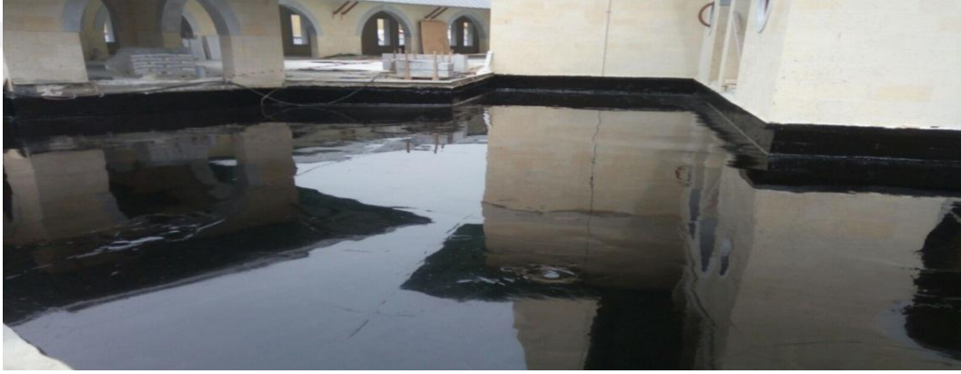
Şekil 3.8. Çift komponentli (Bitüm-Poliüretan) yalıtım uygulaması – TOKİ Camii / İstanbul
