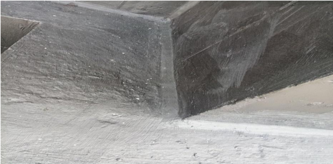
Şekil 4.19. Soğuk derzde fileli tamir harcıyla pah yapılması
