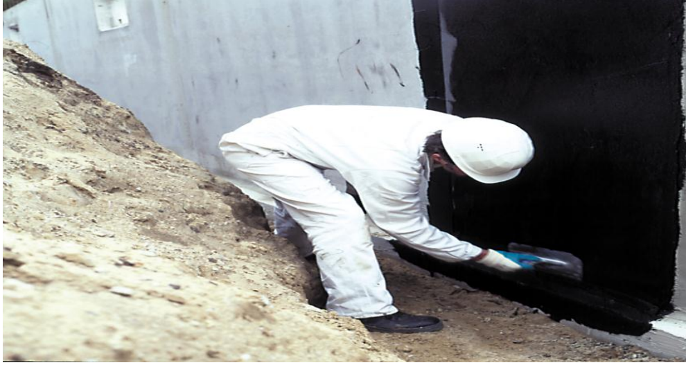
Şekil 3.7. Bitüm esaslı sürme tip yalıtım uygulaması
