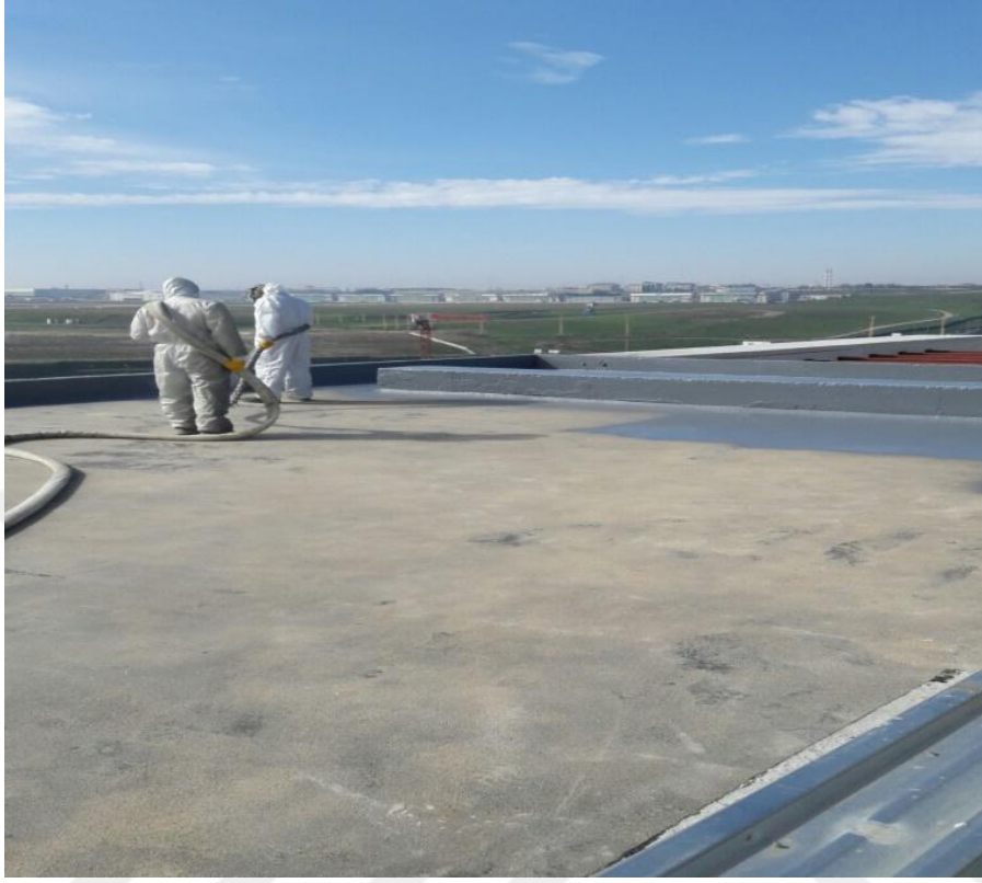
Şekil 3.10. Poliüretan esashı püskürtme yalıtım uygulaması – Karat 34 / İstanbul
