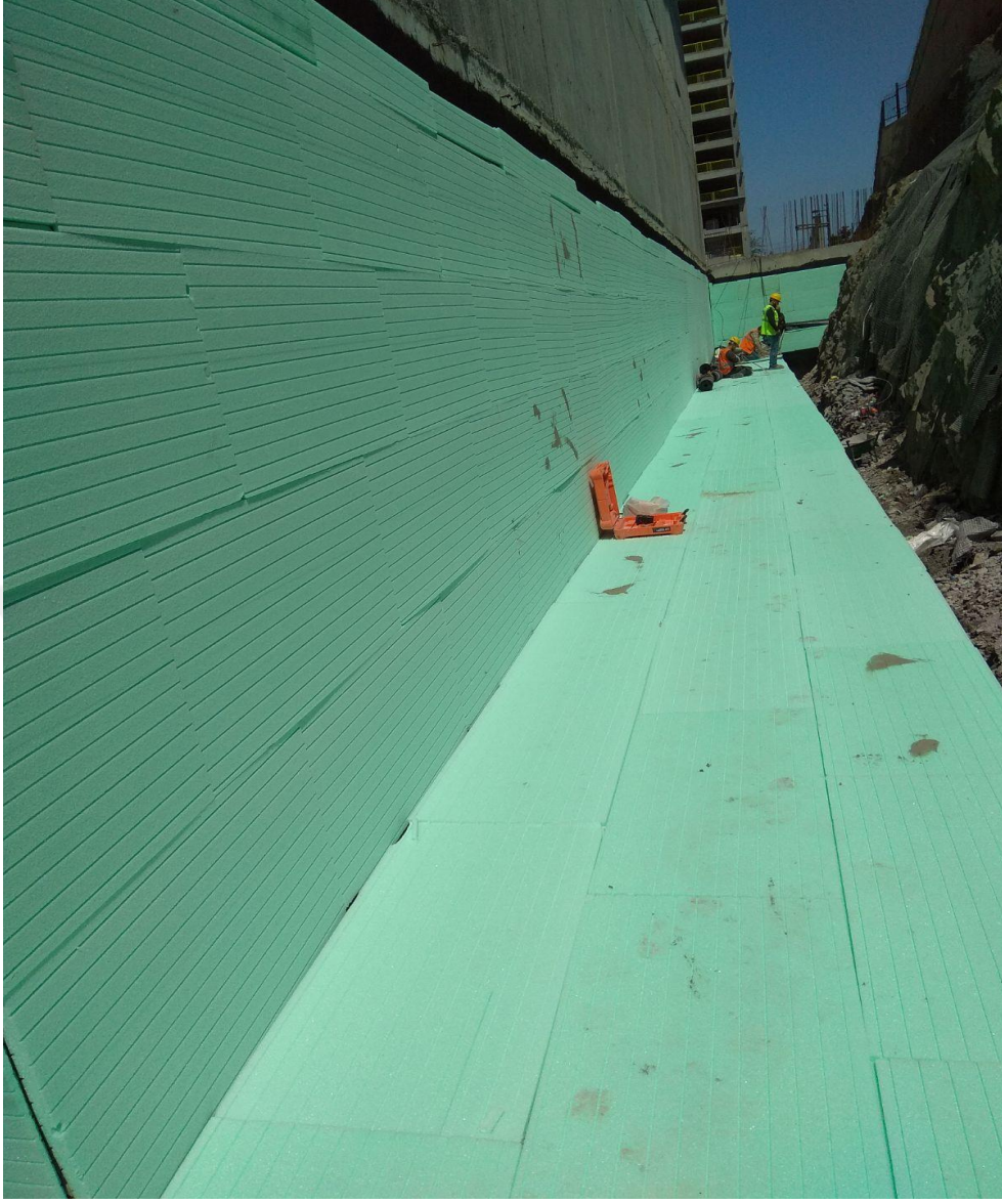
Şekil 4.21. Yalıtım üzerine XPS serilmesi
