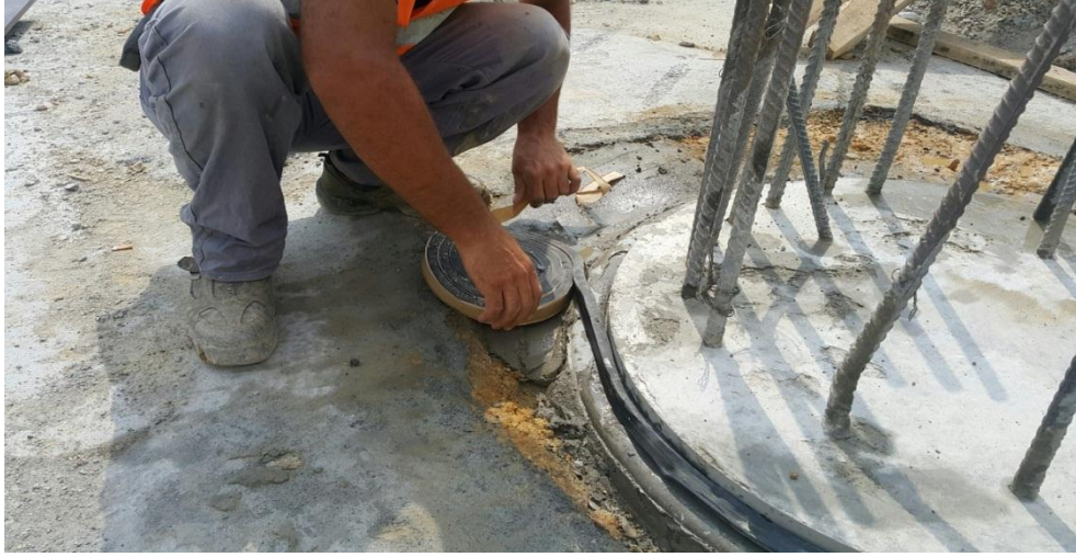
Şekil 3.13. Kazık başı yalıtımında şişen bant kullanımı Nidapark Kayaşehir / İstanbul
