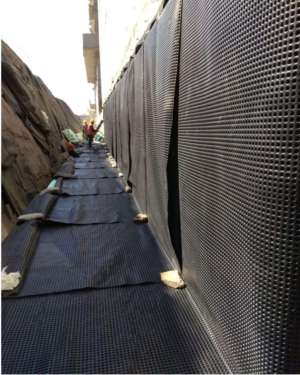
Şekil 4.22. HDPE esaslı drenaj levhası serilmesi
