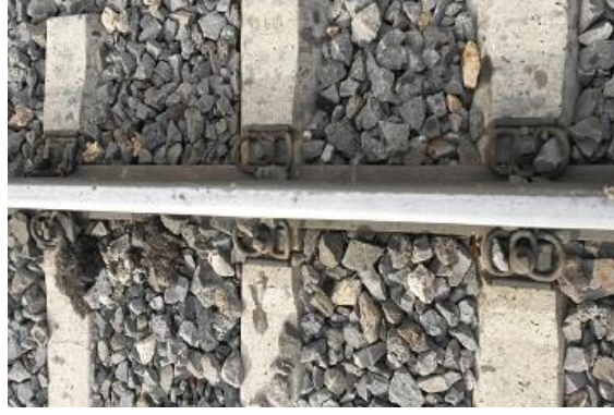
Şekil 2.7. Betonarme türündeki traversler
