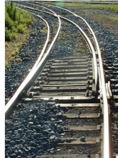
Şekil 2.12. Simetrik basit makas geçişi
