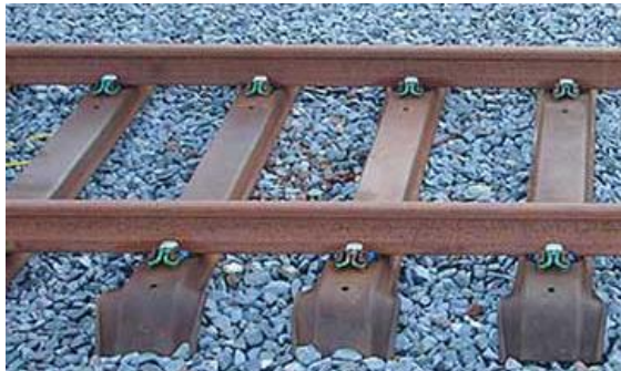
Şekil 2.6. Çelik türündeki traversler [74]
