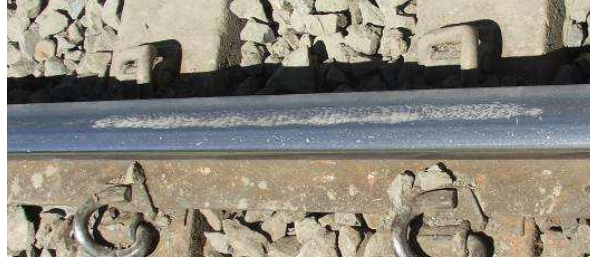
Şekil 2.24. Tekerlek yanıklarını gösteren bir ray profili [78]
