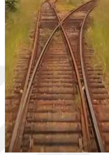
Şekil 2.11. Örnek sağ basit makas geçişi
