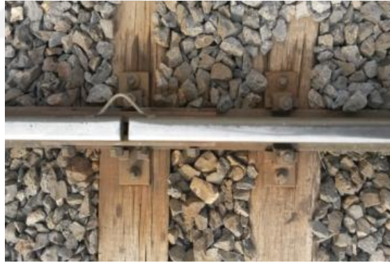
Şekil 2.5. Ahşap travers örneği
