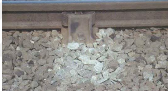
Şekil 1.4. Demiryollarındaki balast örneği
