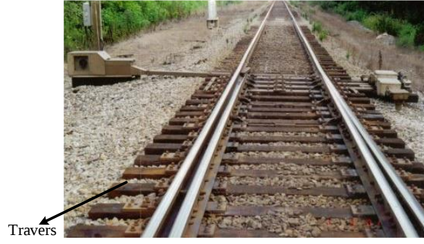
Şekil 1.3. Demiryollarındaki travers örneği
