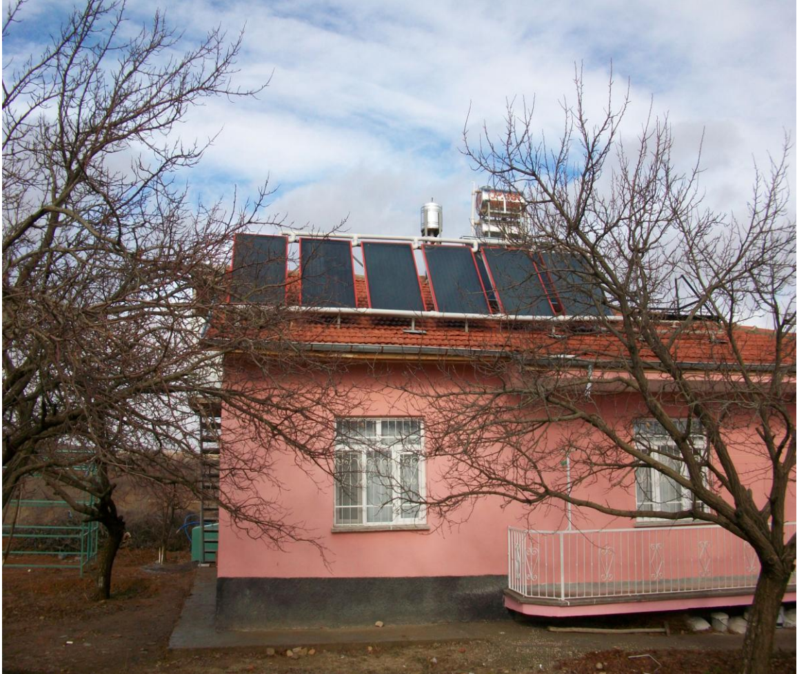
Şekil 3.13. Güneş kollektörlerinin ve genişleme deposunun bina üzerindeki genel görünümü
