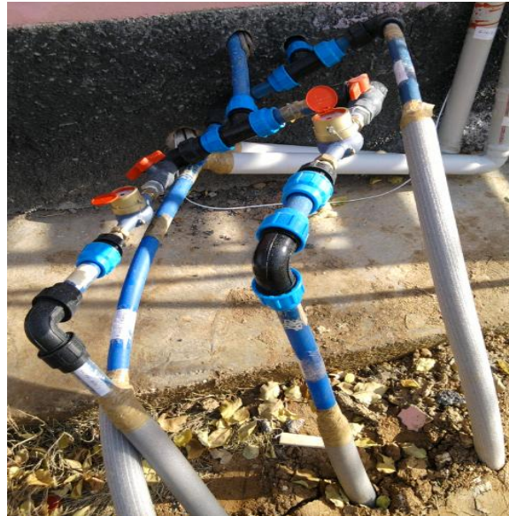
Şekil 3.6. TID girişlerindeki su sayaçları ve vanalar
