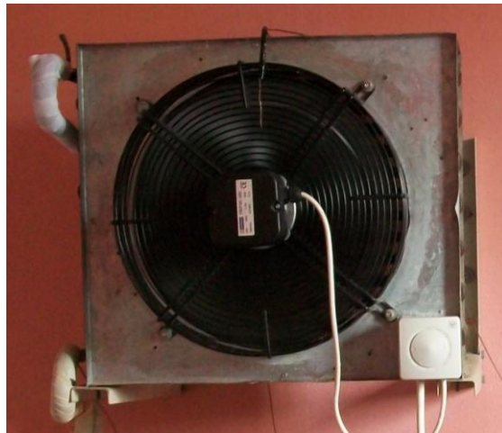
Şekil 3.5. Kondenser ve fanın birlikte görünümü
