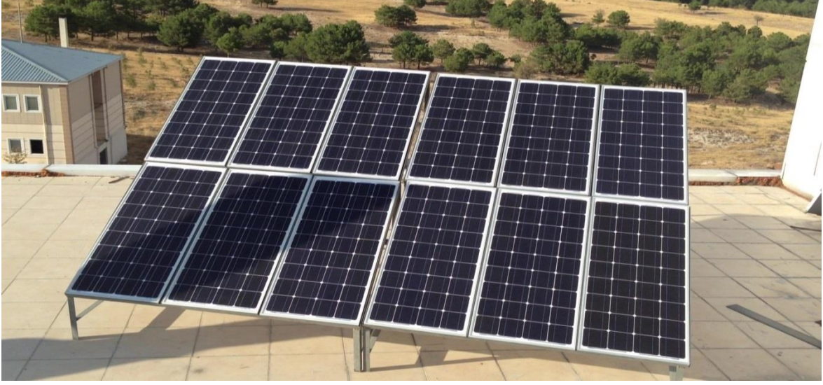
Şekil 1.4. Örnek bir PV dizi sahnesi ve gölgelenmesi [31]
