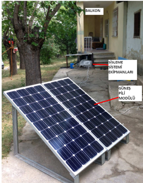
Şekil 4.4. Balkon serinletilmesi sistemi
