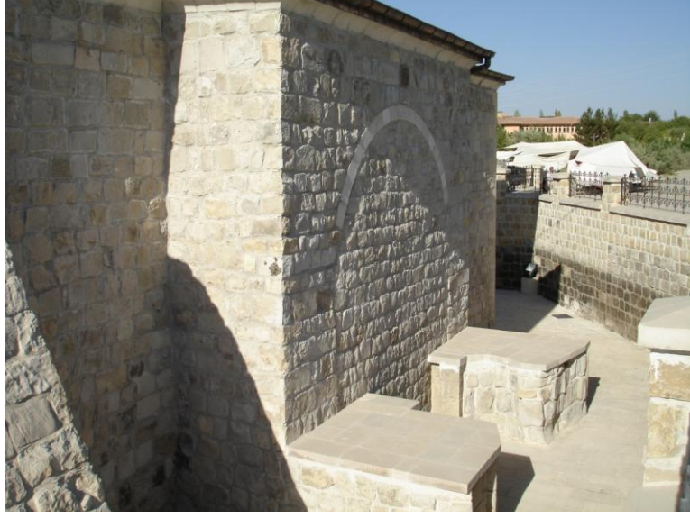
Şekil 5.8. Malatya Ulu cami kapatılan güney kapısının görünüşü
